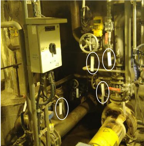
Kuva 14. Väliaikaiset laitemerkinnät
