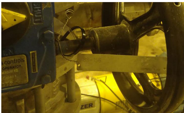
Kuva 16. Laitepositiokilpi
