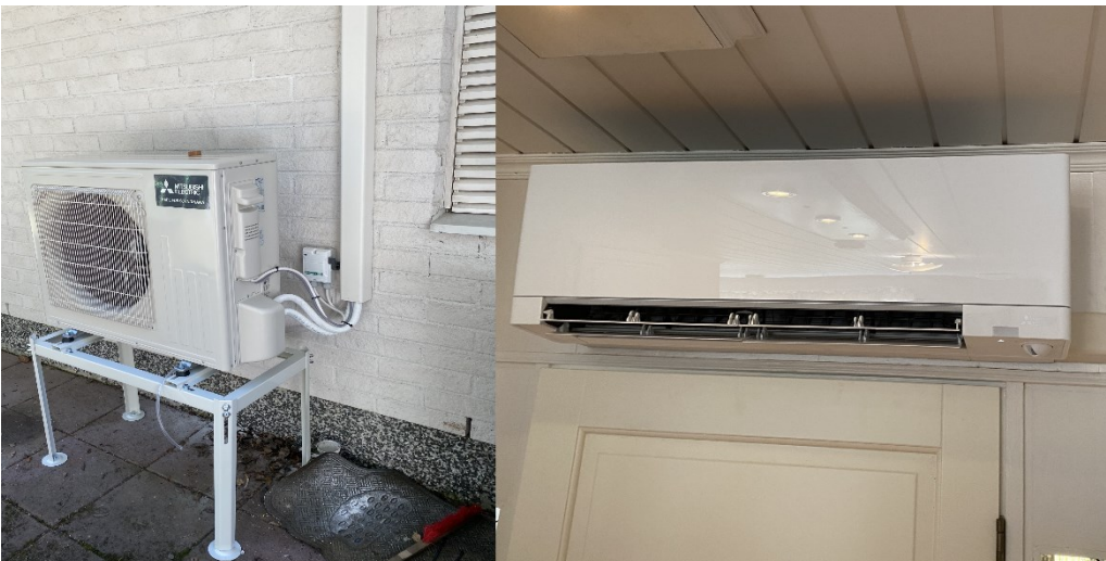
Kuva 25. Ilmalämpöpumpun asennuksen lopputulos (Kananoja, 2023).
