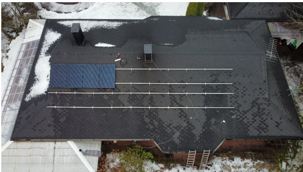
Kuva 27. Aurinkopaneelien asennus aloitettu (Kananoja, 2023).
