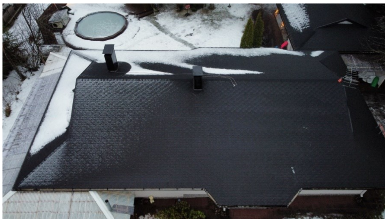
Kuva 17. Kohteen omakotitalon katon etelälape (Kananoja, 2023).
