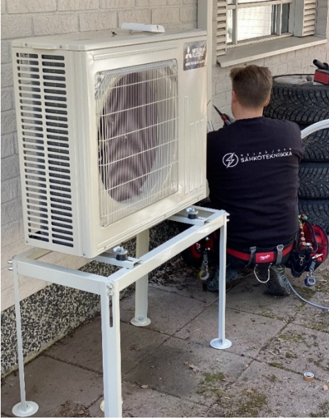
Kuva 24. Ilmalämpöpumpun viimeiset kytkennät (Kananoja 2023).
