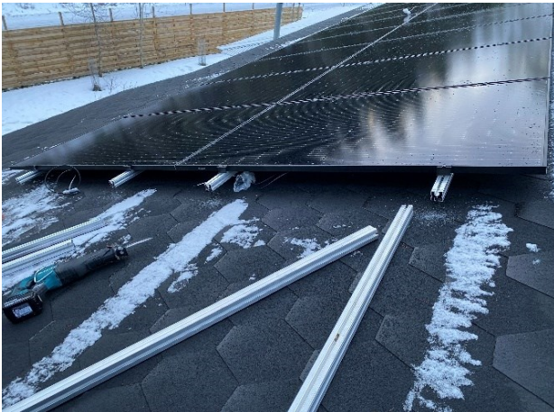
Kuva 29. Telineiden päätyjen katkaisu (Kananoja, 2023).
