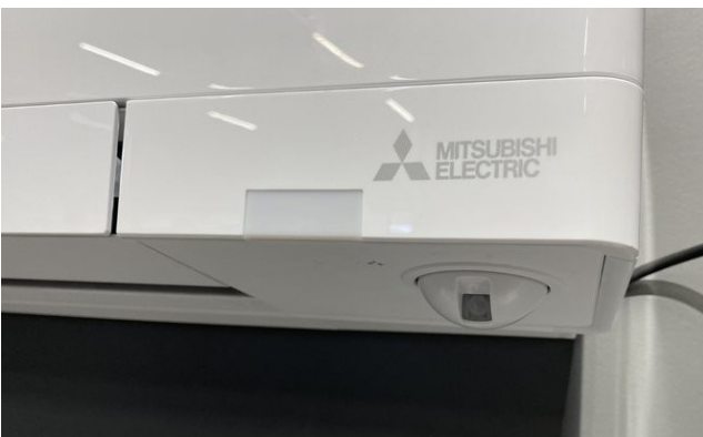
Kuva 14. Kohteen ilmalämpöpumpun i-see-sensor (Seinäjoen Sähkötekniikka, henkilökoh- tainen tiedonanto, 2023).
