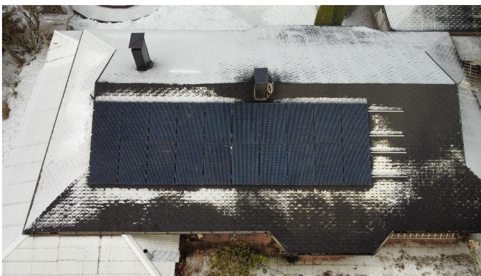
Kuva 28. Aurinkopaneelit kiinnitettynä (Kananoja, 2023).
