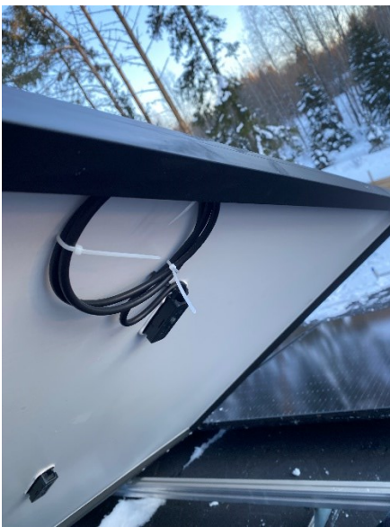
Kuva 35. Kytkemättä jäänyt lenkki (Kananoja, 2023).
