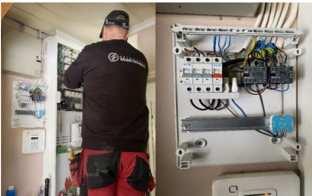
Kuva 33. Plejd-järjestelmän asennus (Kananoja, 2023).
