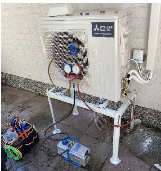
Kuva 23. Kylmäaineen lisäys ilmalämpöpumpun yksikköön (Kananoja, 2023).
