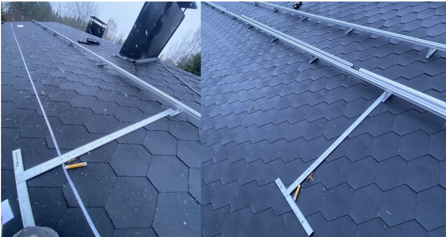
Kuva 26. Aurinkopaneelien mittojen merkintä katolle (Kananoja, 2023).
