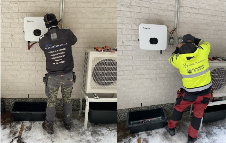
Kuva 31. Invertterin sekä turvakytkimien asennus (Kananoja, 2023).
