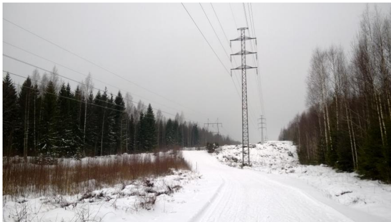
Kuva 4. Voimalinjan alla kulkeva latupohja
