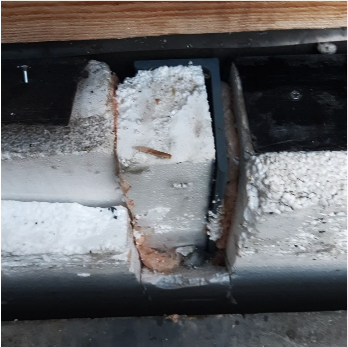
Kuva 37. Hitsattava kohde styroksieristeiden välissä.
