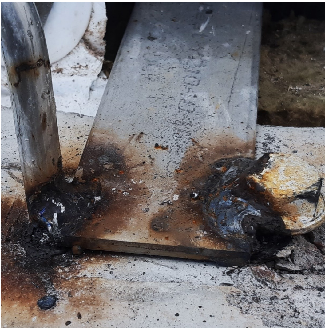
Kuva 3. Puuttuva asennuspinta korvattu hitsaamalla kiinnitysrauta nostolenkkiin ja betoniruuviin.
