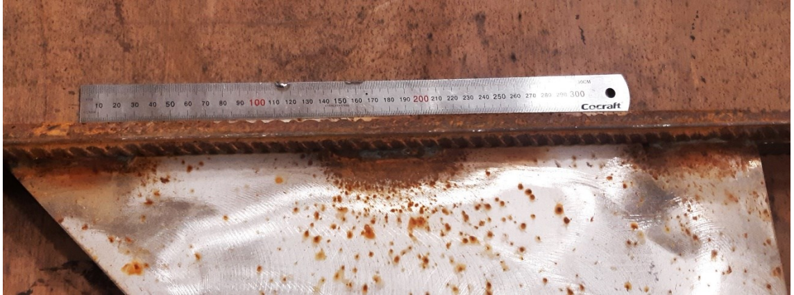
Kuva 26. Työmaan C korjattava osa.
