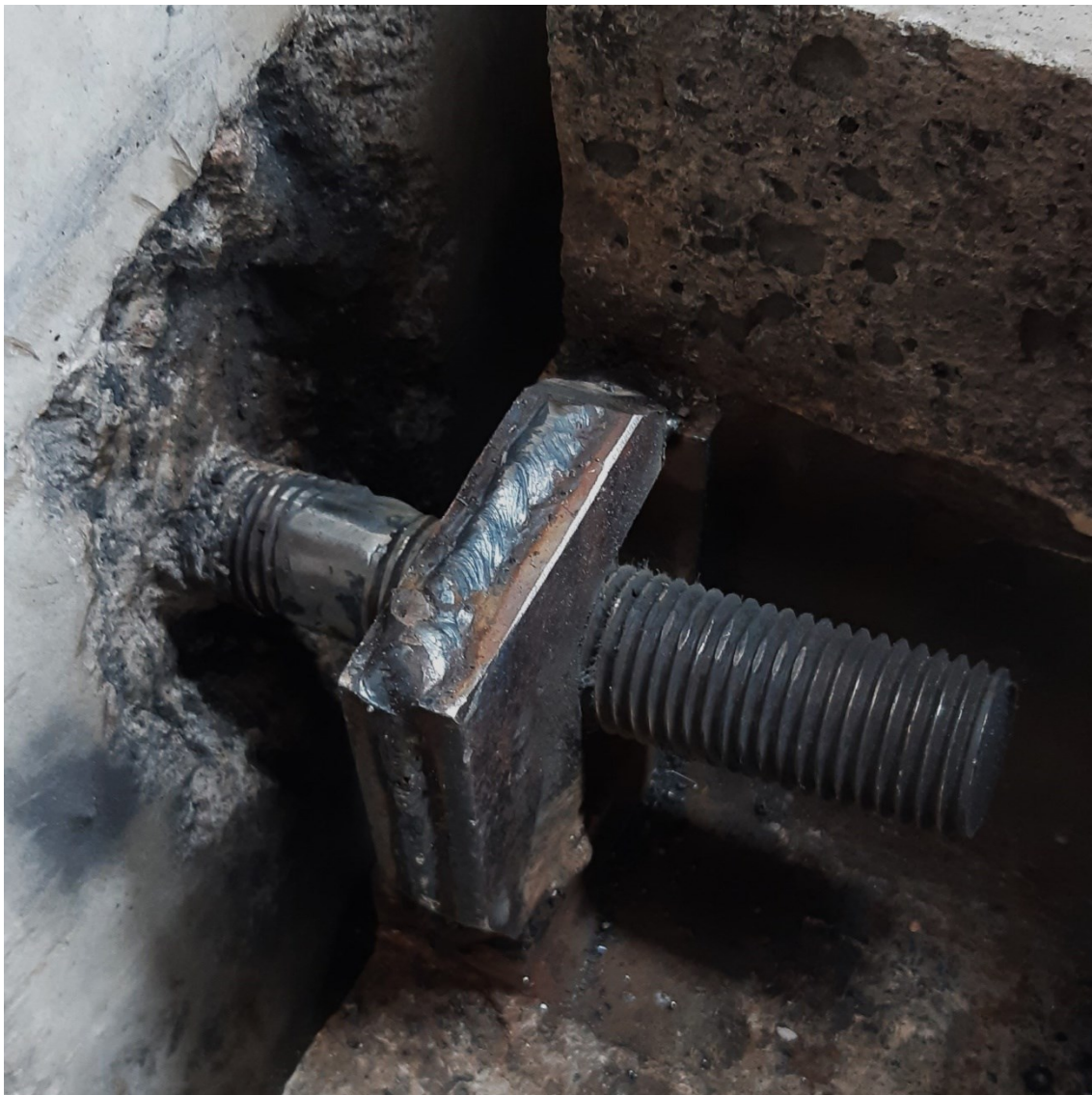
Kuva 25. Kuvan 19 kohde korjauksen jälkeen.
