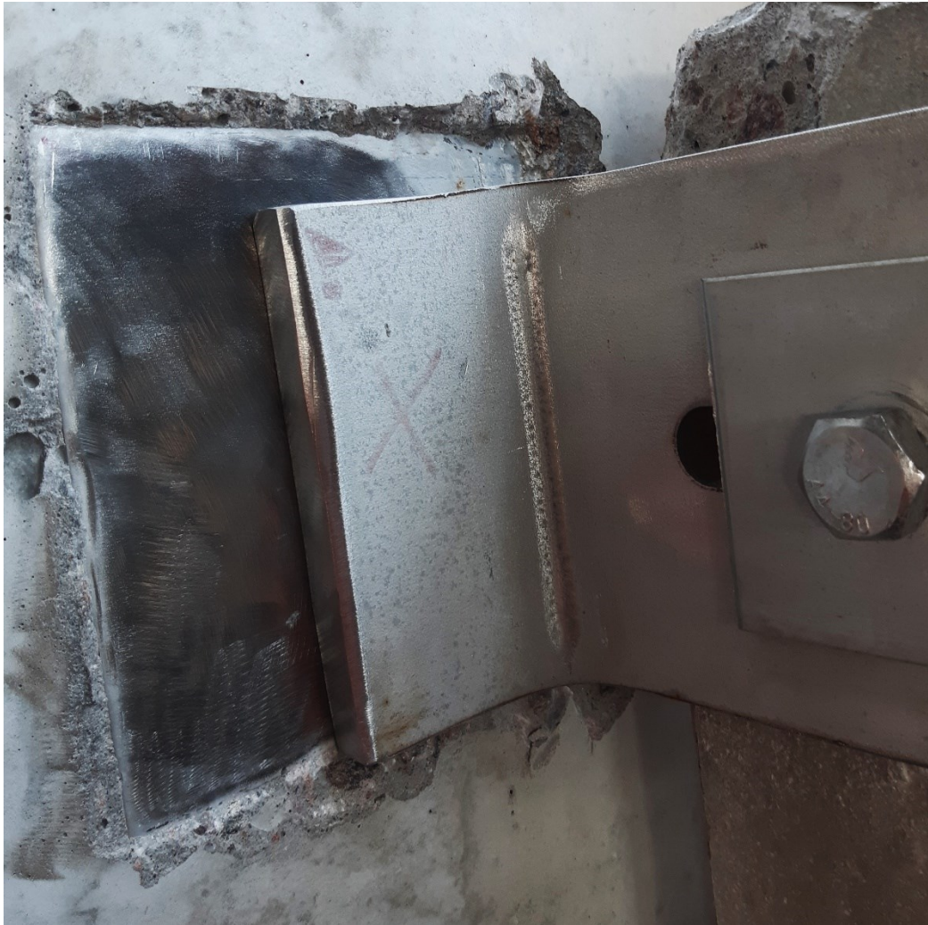
Kuva 35. Kuvan 28 kohde sovitettuna esivalmisteltuun asennuspintaan.
