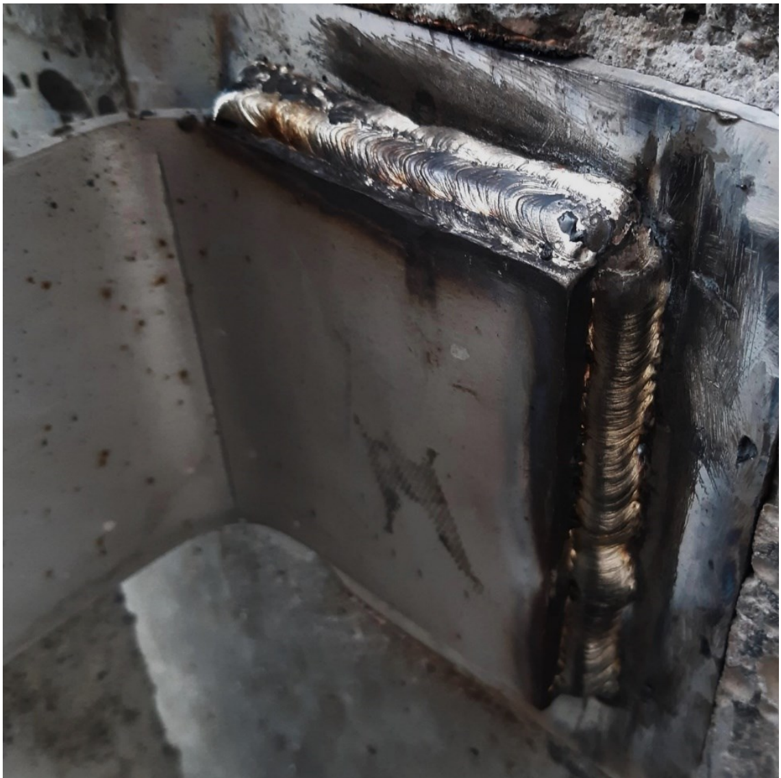
Kuva 20. Kuvan 10 kohde korjattuna.
