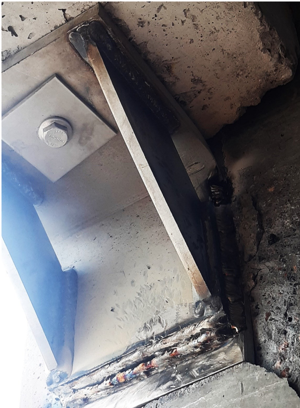
Kuva 22. Kuvan 14 kohde korjattuna.
