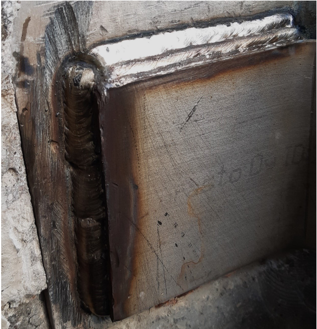
Kuva 21. Kuvan 11 kohde korjattuna.
