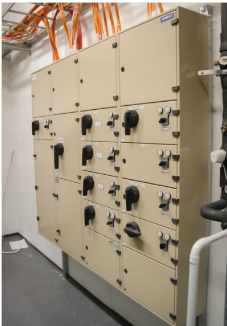
Kuva 2. Esimerkki kotelokeskuksesta (Norelco Oy, 2022)
