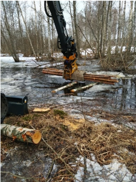
Kuva 18. Viimeisiä nippuja upotettiin veteen koivupedin päälle.
