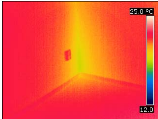
Kuvio 4: Lämpökuva lämpötila-asteikossa 12 - 25 °C
