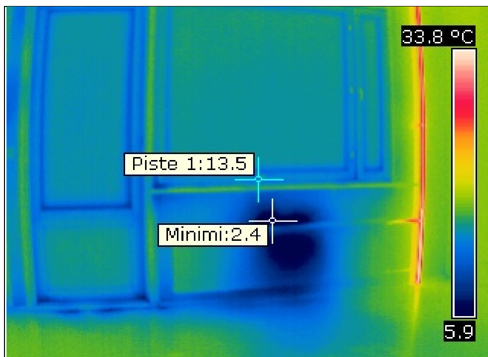
Kuvio 3: Korvausilmalaitteen (Vimin) aiheuttama veto kuvattuna lämpökameralla silloin, kun patteritermostaatti on kiinni ja ikkunassa on kukkalauta.
