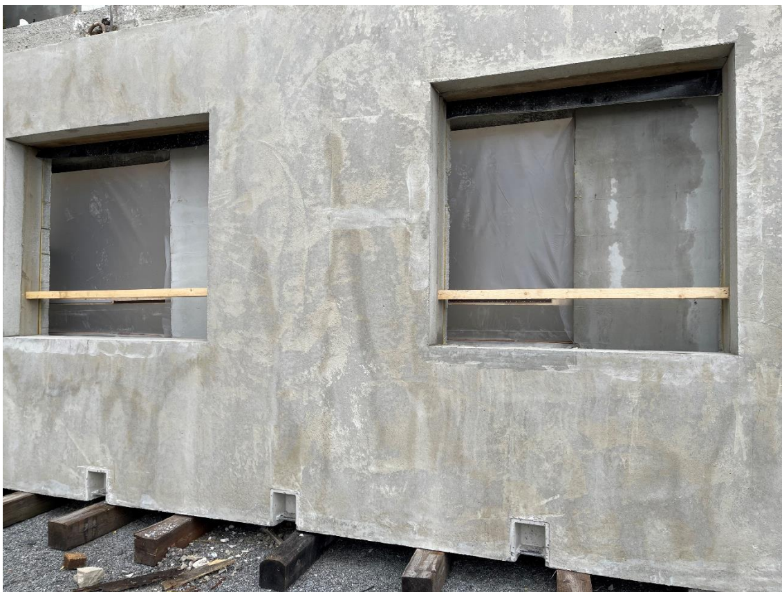
Kuva 10. Ulkoseinä elementti (Aleksi Renko)
