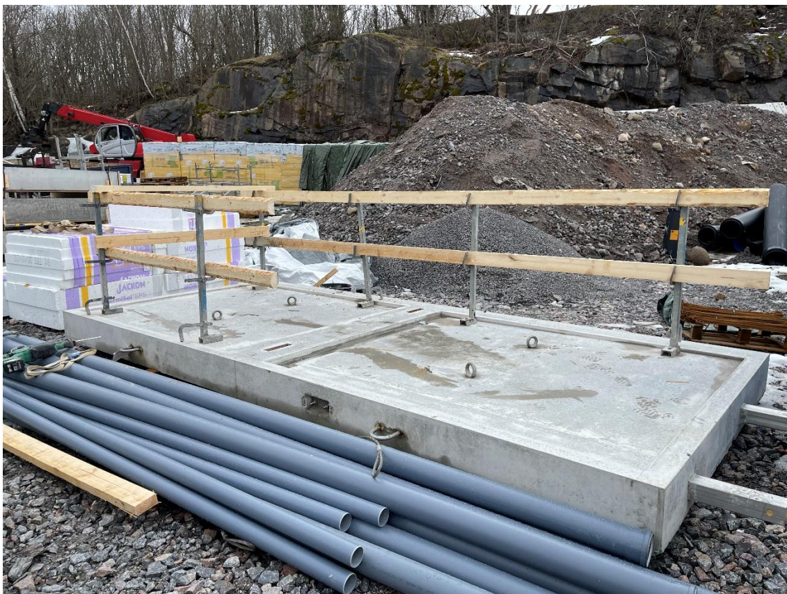
Kuva 9. Elementti, johon on kiinnitetty putoamissuojaus maassa (Aleksi Renko)
