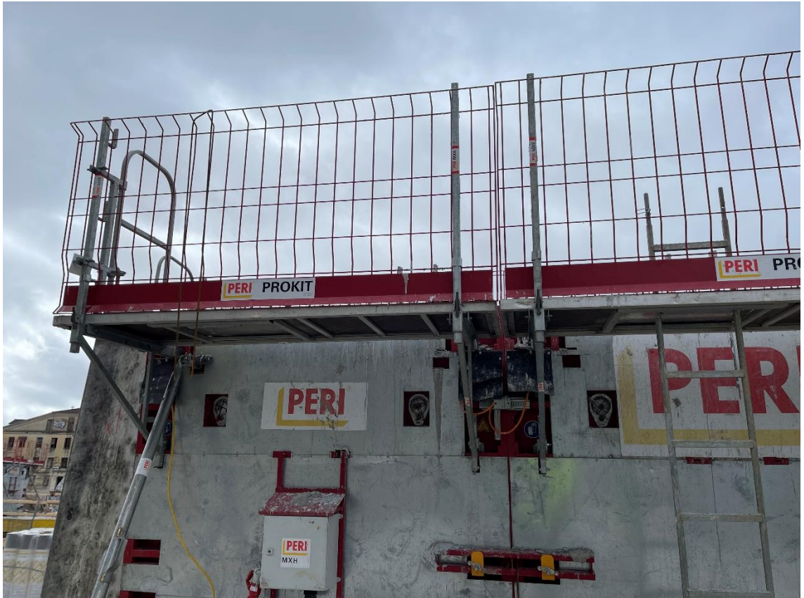
Kuva 12. Seinämuotin putoamissuojaus (Aleksi Renko)
