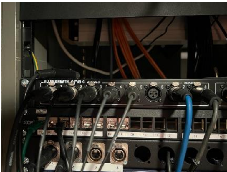
Kuva 18. AR84-ääniteline, sekä mikrofonien kaapelointi porteissa 1–5, vihreä RJ45-verkkokaapeli käyttää dSNAKE-verkkoprotokollaa siirtäen äänen näyttämöltä
