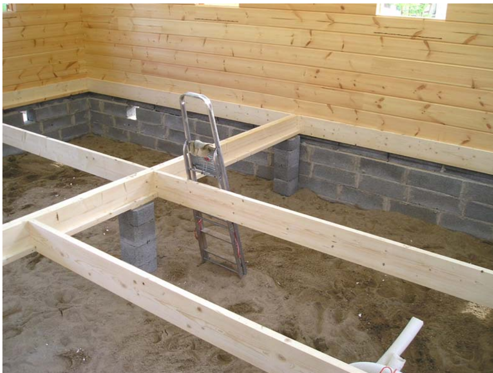
Kuvassa rossipohjivasojen asennus
