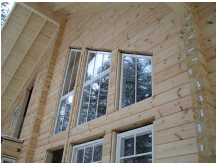
Kuvassa ikkunat asennettuna
