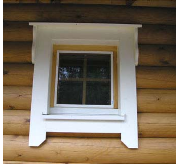
Ulkopuolen vuorilaudat asennettuna.
