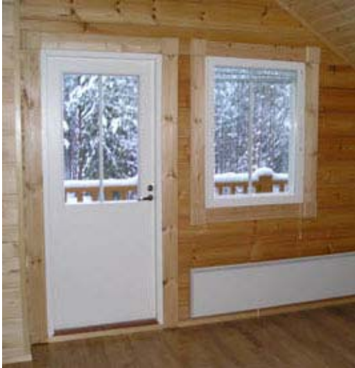
Sisäpuolen vuorilaudat asennettuna.
