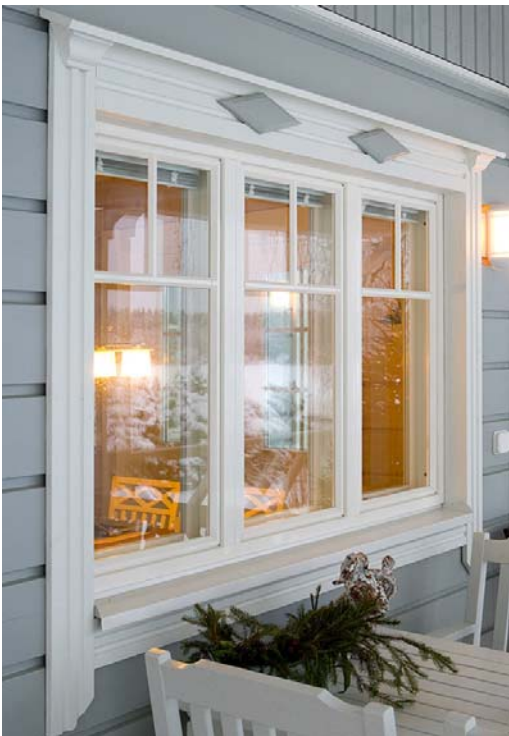
Kartanohirren ulkopuoliset vuorilaudat asennettuna. Vuorilautojen viisteet tehdään työmaalla.
