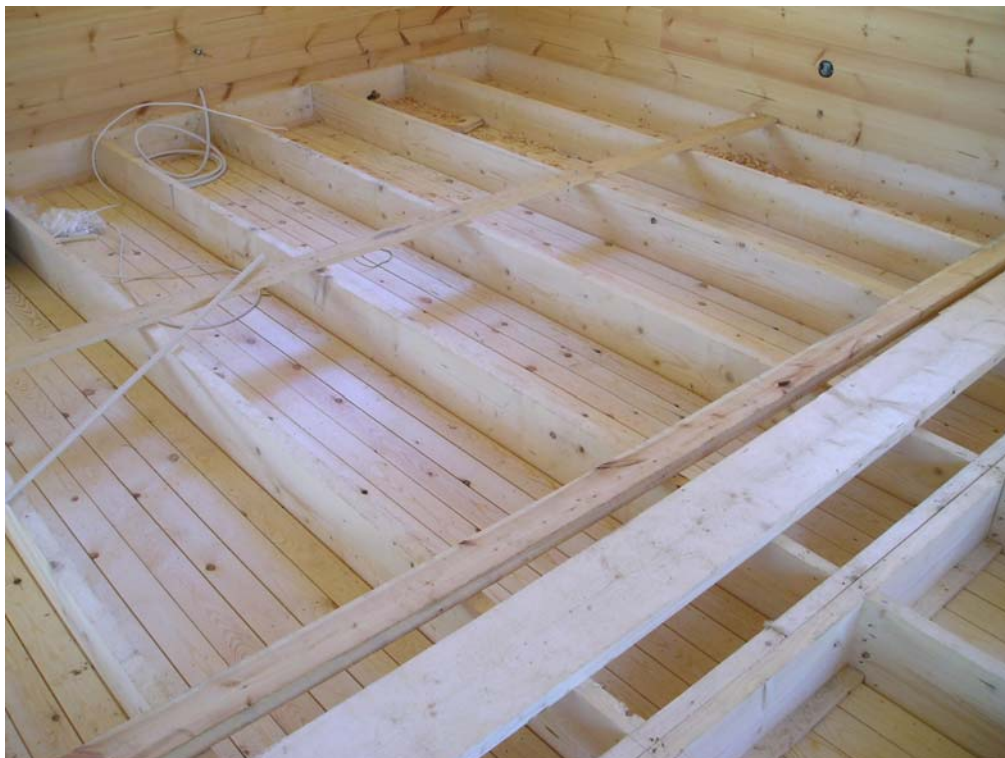
Kuvassa raakaponttilaudat asennettu pituussuuntaan.
