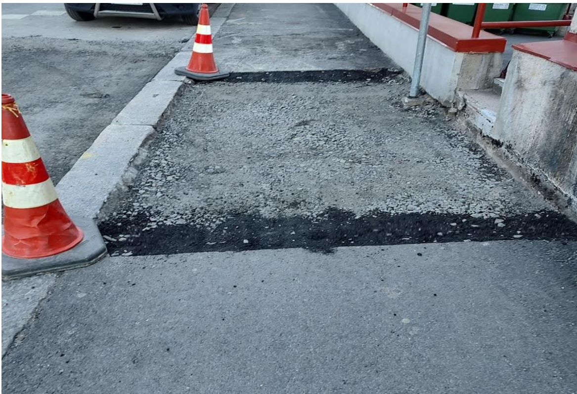
Kuva 12. Valmiit pohjat, jossa saumat loivennettu PAB-V massalla
