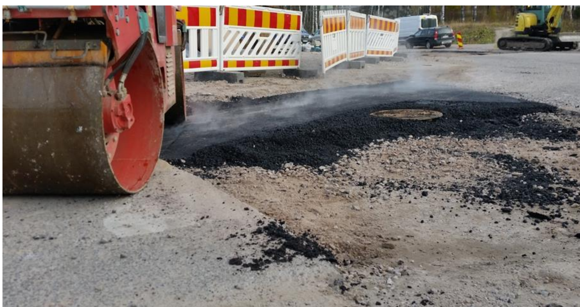
Kuva 5. Asfaltointi käynnissä katuluokan 3 kadulla
