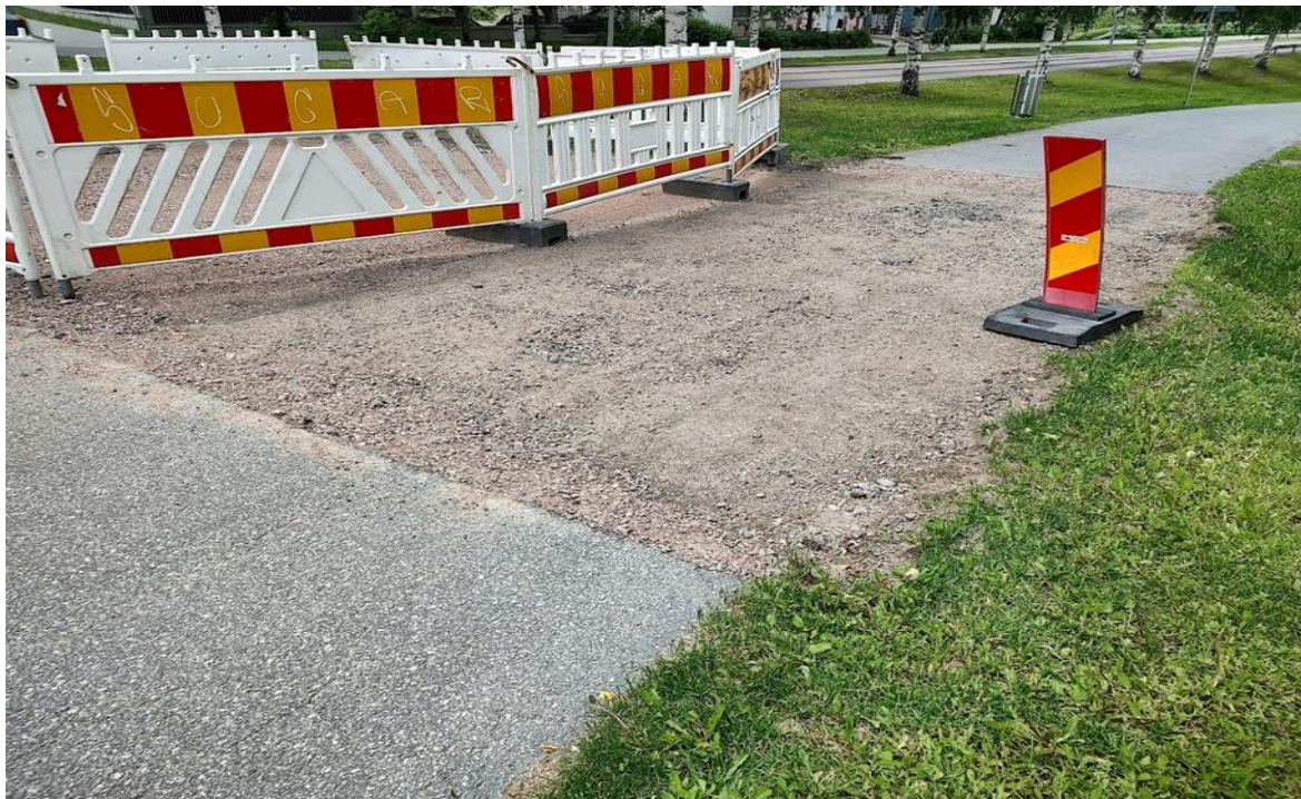
Kuva 11. Valmiit pohjat, jossa saumat loivettu murskeella
