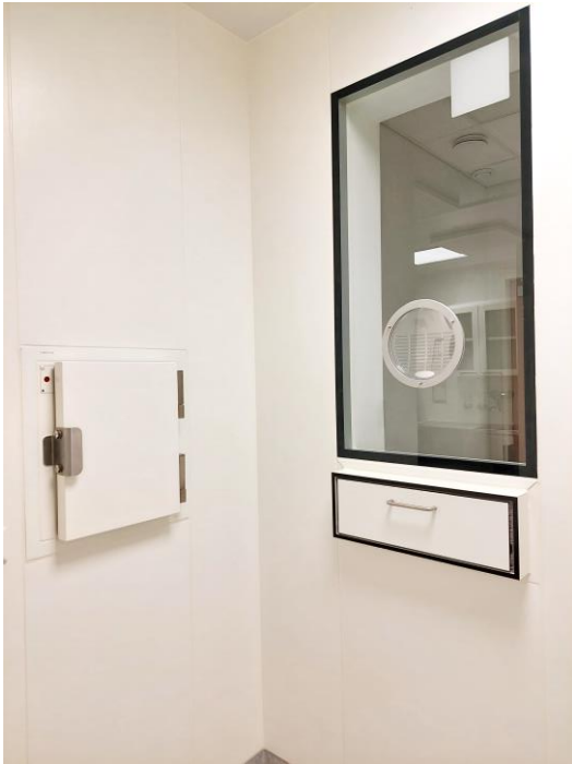
KUVA 7. OYS 2030, laboratorion läpientokaappi ja -laatikko (kuva: Tiia Hautajärvi)
