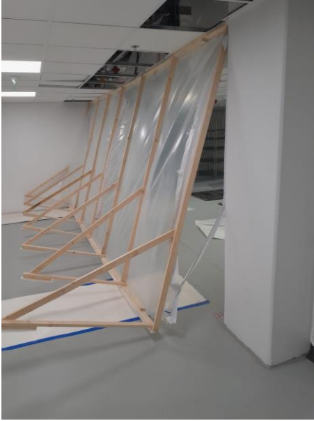
KUVA 15. OYS 2030, puurunkoisen suojaseinän rakentaminen (kuva: Tii Hautajärvi)
