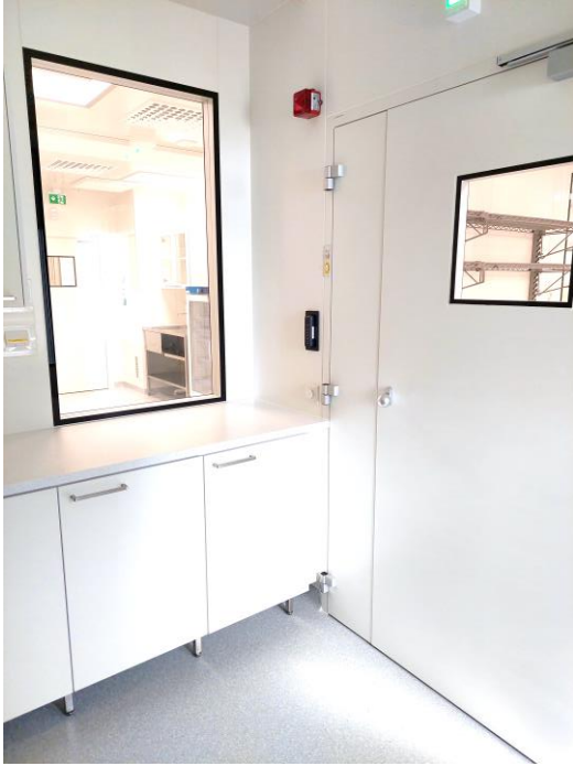
KUVA 3. OYS 2030, laboratorion sulkutila (kuva: Tiia Hautajärvi)
