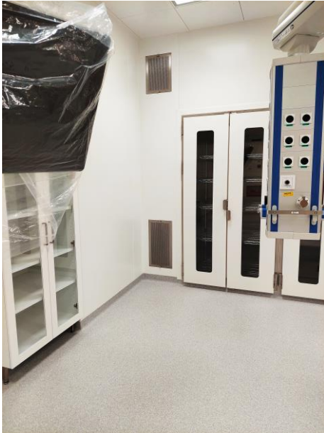
KUVA 11. OYS 2030, leikkaussalin ilmanvaihto ja läpientokaapit (kuva: Tiia Hautajärvi)
