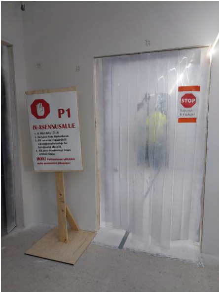
KUVA 16. OYS 2030, eristetty P1-alue väliaikaisella muovisulkuovella (kuva: Tii Hautajärvi)
