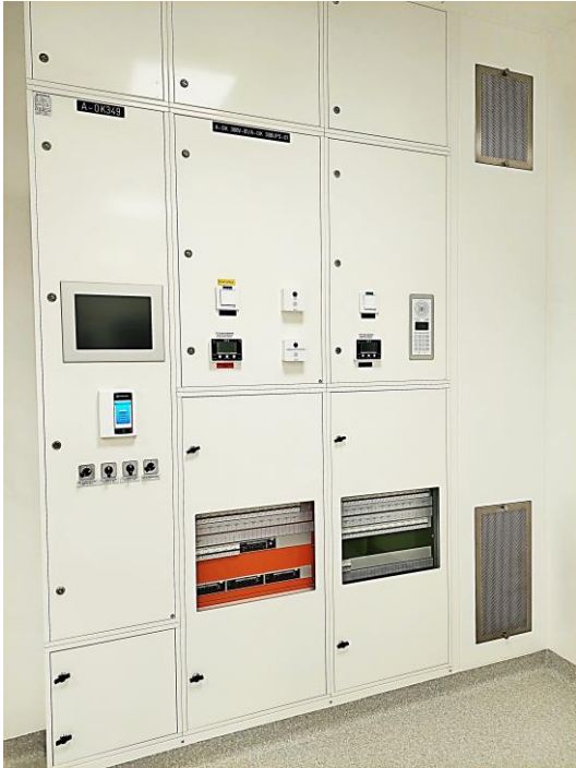
KUVA 10. OYS 2030, leikkaussalin keskusyksikkö (kuva: Tiia Hautajärvi)
