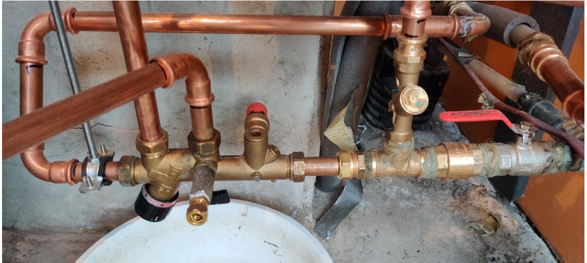
Kuva 11. Syöttösekoitus- ja verkoston täyttöventtiili.
