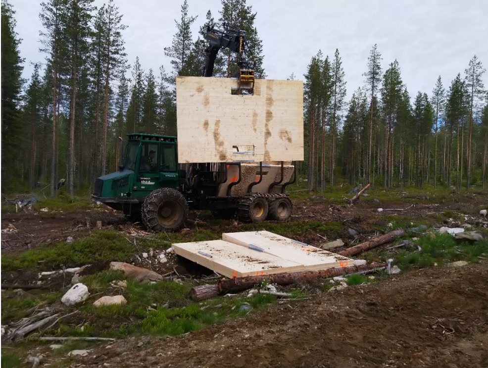
Kuva 1. Kuormauksessa leveä CLT-levy, jossa nosto teräksellä vahvistetusta aukosta. Maassa olevissa, ojien ylitykseen tarkoitetuissa levyissä nosto tapahtuu metallisesta rivasta. (Kuva Anu Hilli)
