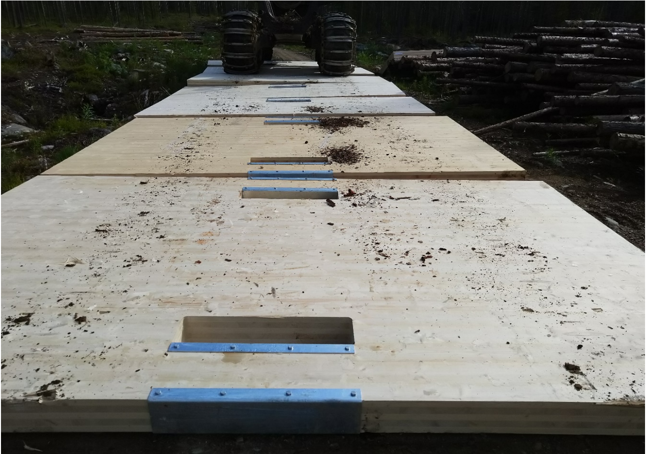
Kuva 3. Käytössä 2500 mm levyisiä CLT-levyjä nostoratkaisuineen. (Kuva Anu Hilli)
