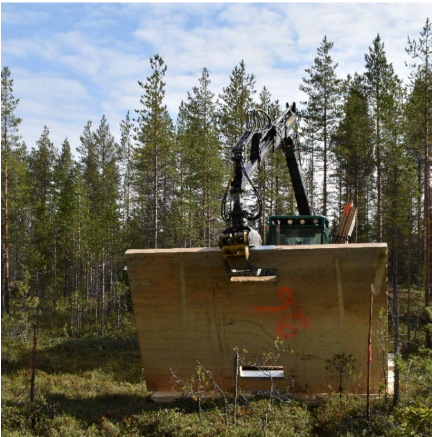
Kuva 3. Kuormatraktorin nosturin ulottuvuus ja liikeratojen laajuus vaikuttivat CLT-levyjen käsittelyyn. (Kuva Harri Lindeman)
