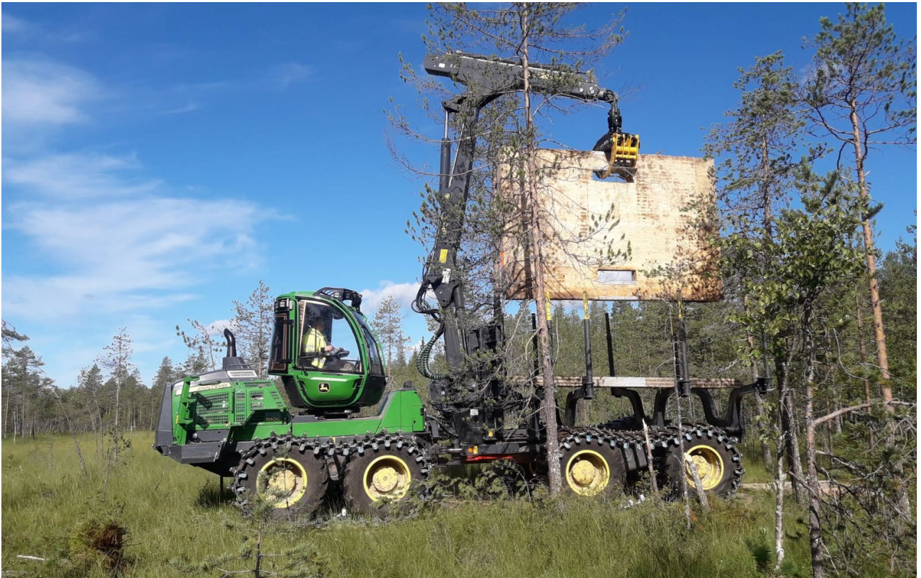
Kuva 1. Teräksellä vahvistettu CLT-levyn nostoratkaisu. (Kuva Jari Lindblad)
