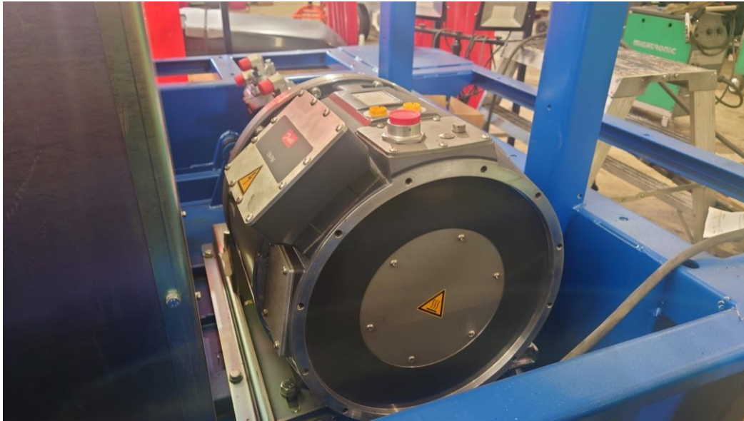
Figur 16. Motorn installerad i arbetsmaskinen.
