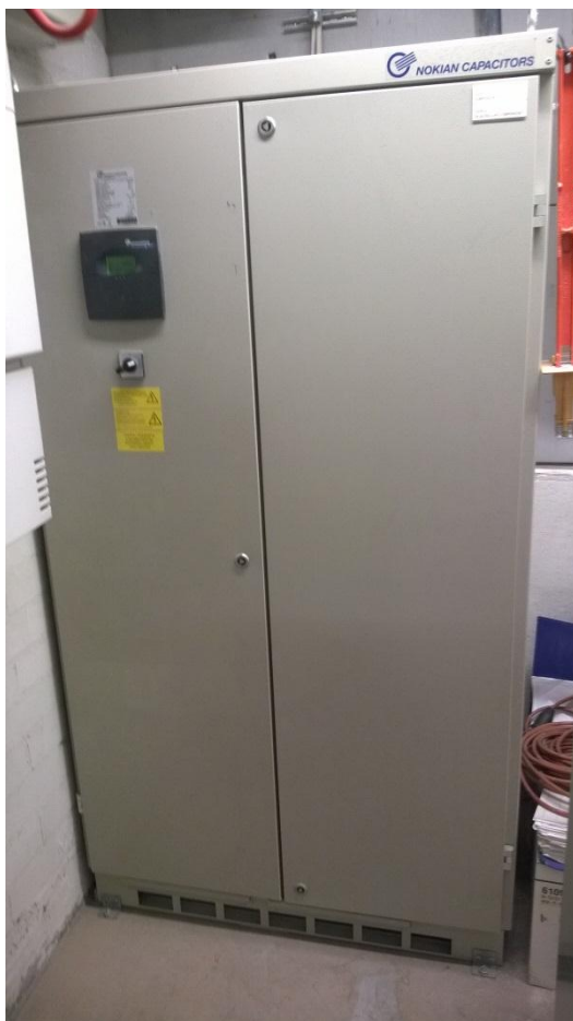
KUVA 15. Kiilletehtaan kompensointilaitteisto.
