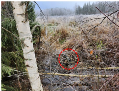
Putki kosteikkoon, kuvaushetkellä veden pinnan yläpuolella.
