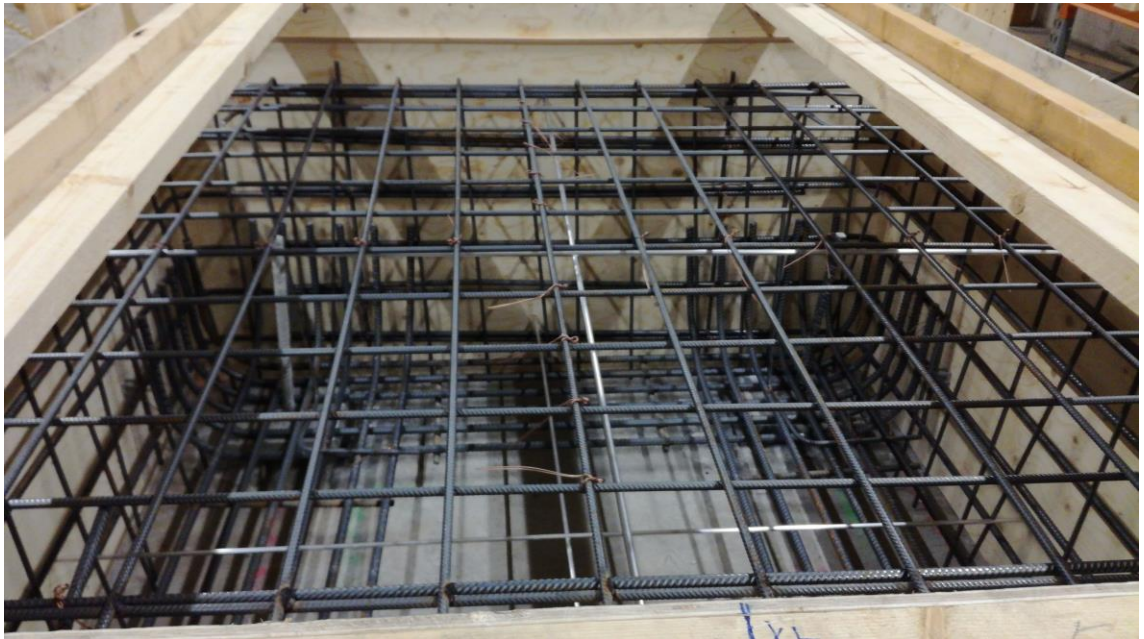
Kuva 10: Valmis neljän paalun antura raudotteineen ennen betonivalua [7].
