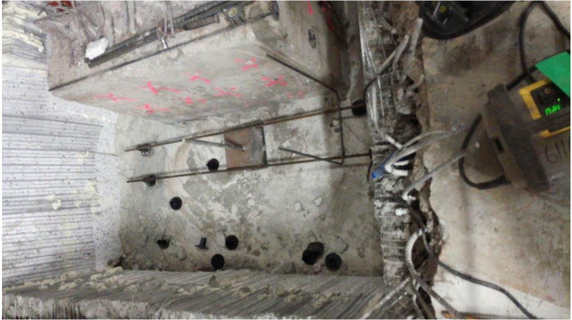
Kuva 11: Vahvistettava kahden paalun antura. Toinen paalu vanhan anturan toisella puolella [7].
