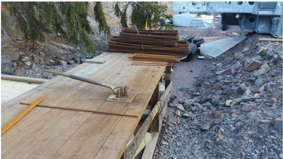
Kuva 1: Käsikäyttöinen hakastaivutin ja väännetyjä raudoitteita [7].
