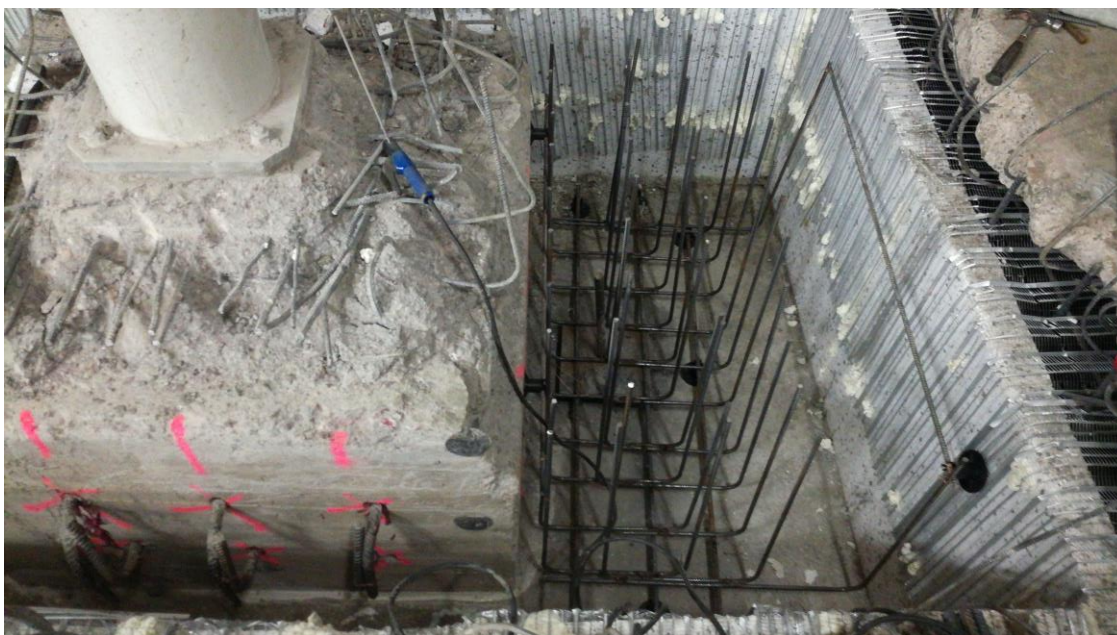
Kuva 12: Vahvistettavan paaluanturan raudoitteita [7].
