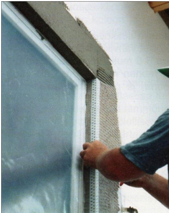
Kuva 11. Kulmalista katkotaan sopivaan mittaan ja kiinnitetään verkotuslaastilla. BY 57, Eriste- ja levyrappaus 2011.
