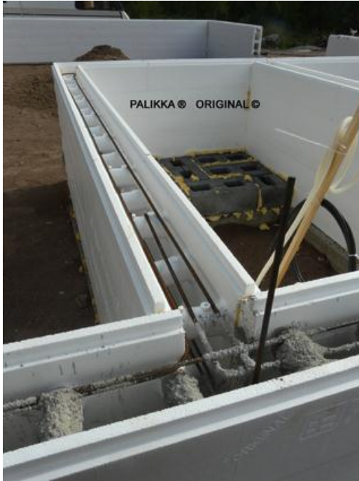
Kuva 27. Väliseinämuotin liitos. Birger Wasenius.
