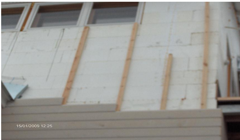
Kuva 2. Puuverhouksen kiinnitys muottiharkon ulkopintaan. Passiivitalon rakentaminen EPS-harkkoja käyttäen, Matti Isotalo, 2009.
