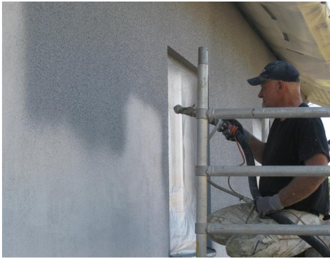
Kuva 13. Ruiskupinnan teko tasoitepumpulla. Räystäät, rännit ja ikkunat ovat suoja- muovitettu.
