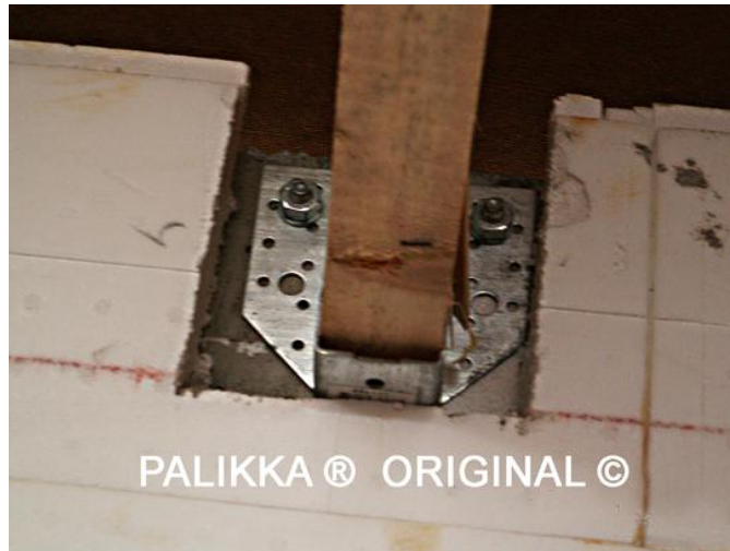
Kuva 29. Puupalkin kiinnitys. Birger Wasenius.
