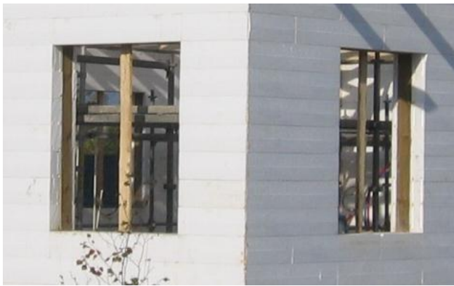
Kuva 15. Aukkojen apukarmit kiinnitettynä rungon betoniin.
