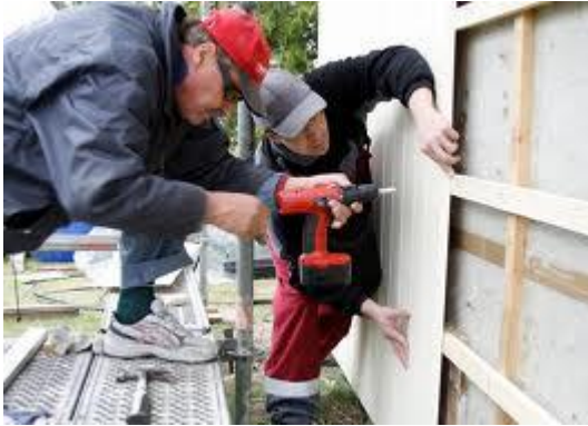
Kuva 3. Pystysuuntainen verhouspaneeli asennetaan ristikoolaukseen, google.fi luettu, 3.9.2014.
