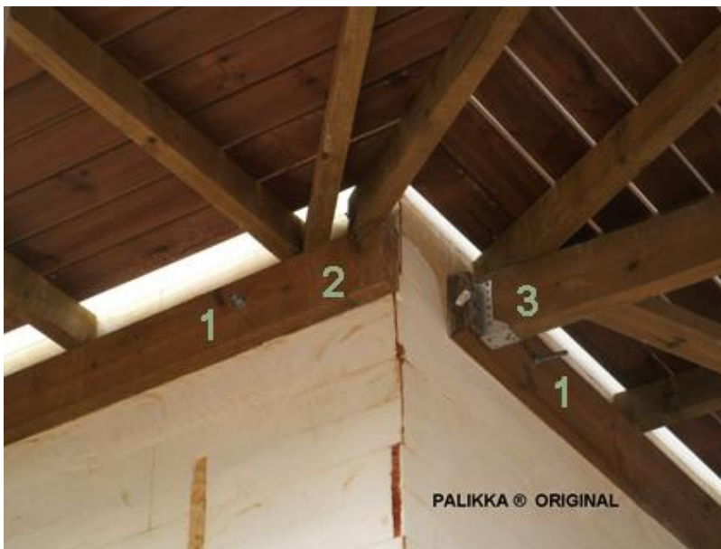
Kuva 32. Kattorakenteiden kannatus. Birger Wasenius.
