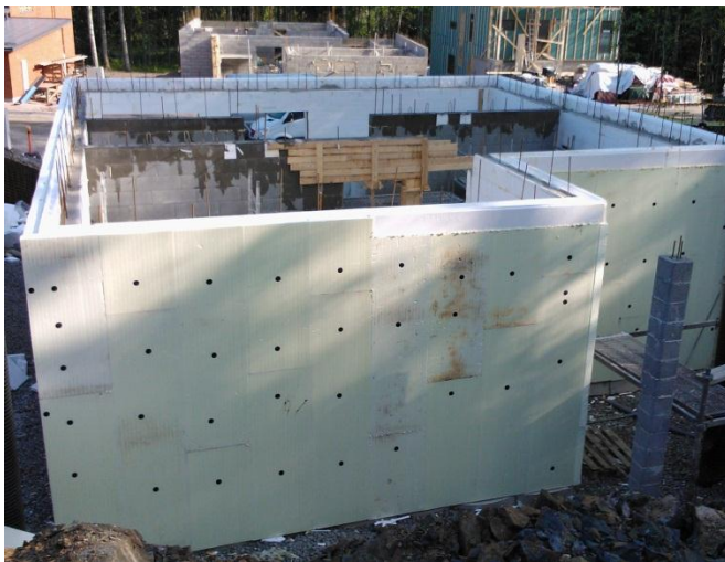
Kuva 21, Finnfoam kellarilevy on kiinnitetty Eps-rakenteeseen eristekiinnikkeillä.
