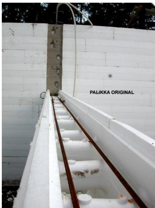
Kuva 26. Ulkoseinän eriste poistetaan betonipintojen välistä. Birger Wasenius.
