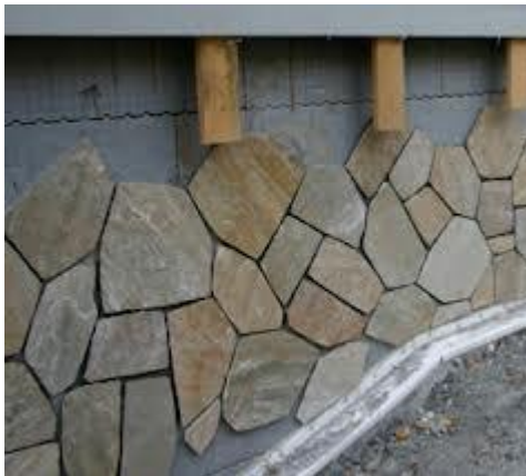
Kuva 1. EPS-harkon pinnoitus kivellä. Finstone.fi, google.fi luettu 12.7.2014.
