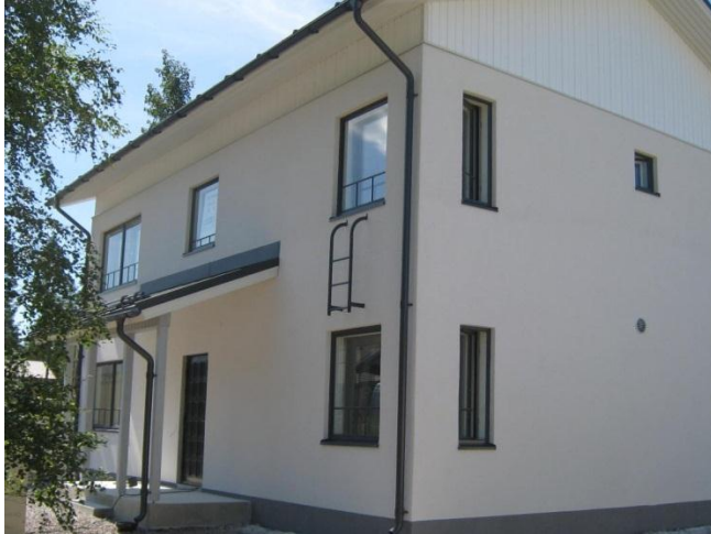
Kuva 4. Valmis rappauspinta. Rännit, poistumistikas, katosrakenne ja rintapelti ovat kiinnitetty.
