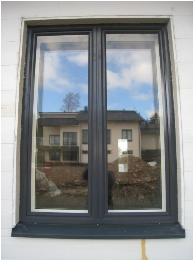
Kuva 5. Ikkunapielien EPS-kaistaleet ja vesipelti on asennettu.
