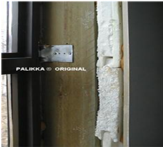
Kuva 18. Kapeakarmisen ikkunan kiinnitys apukarmiin. Kuva Birger Wasenius.
