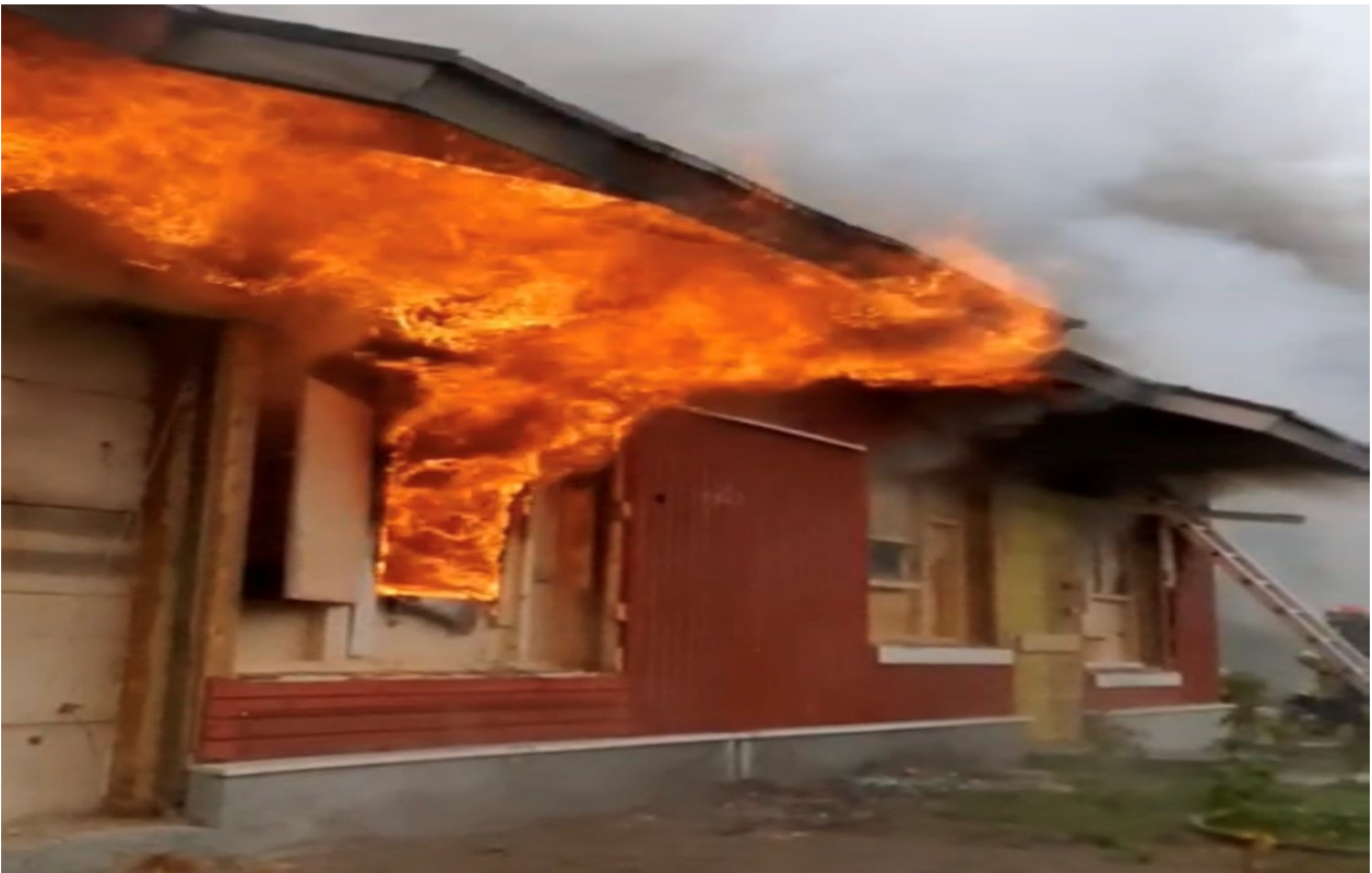
Kuva 15. Tilanne huoneiston takaikkunalla ennen sammutuksen aloittamista.
