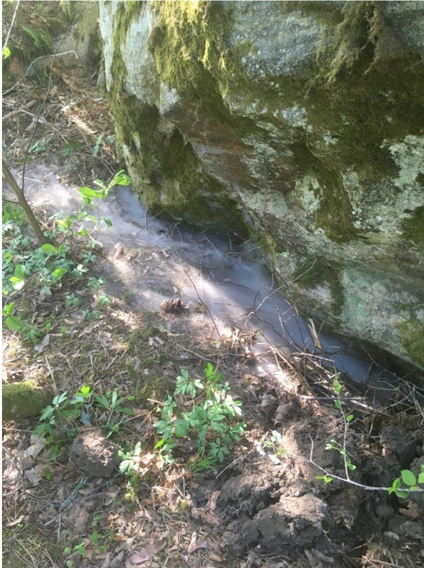
Kuva 14 Maan alta nouseva savu paljasti vioittuneen tonttviemärin.
