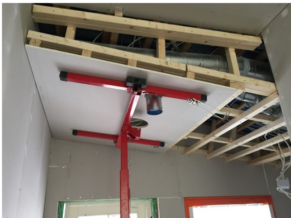
Kuva 4. Rakennusvaiheessa oleva alas laskettu levykatto, johon on tehty kaksi läpivienttiä. [10].
