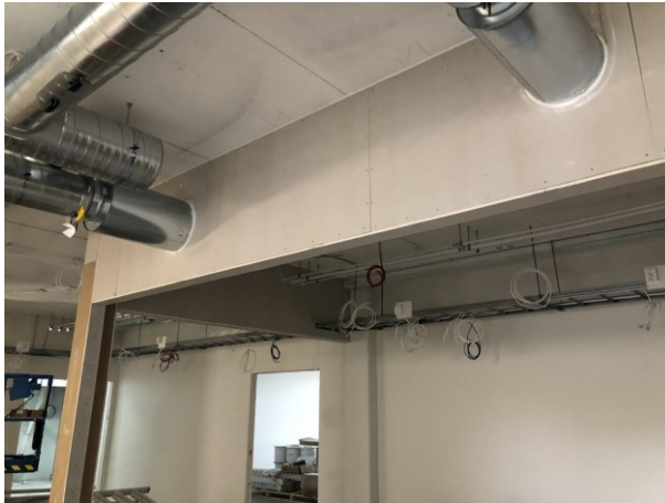
Kuva 3. Kipsilevyrakenteinen otsa, johon on tehty ilmanvaihtoputkille läpiviennit. [9].
