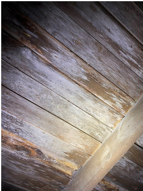
KUVA 15. Mikrobikasvustoa aluslaidoituksessa (Huusko 2023)
