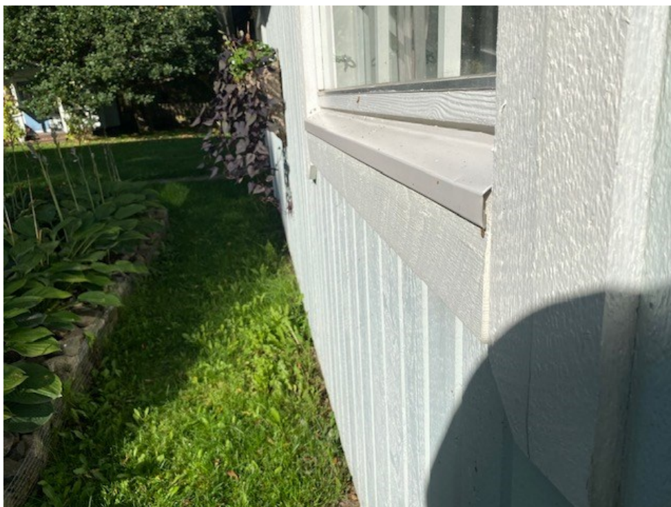
KUVA 25. Liian lyhyt ikkunan tippapelti. (Huusko 2023)
