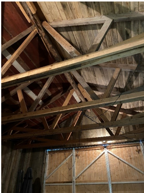
KUVA 16. Havainnekuva katon kantavien rakenteiden korjauksesta (Huusko 2023)
