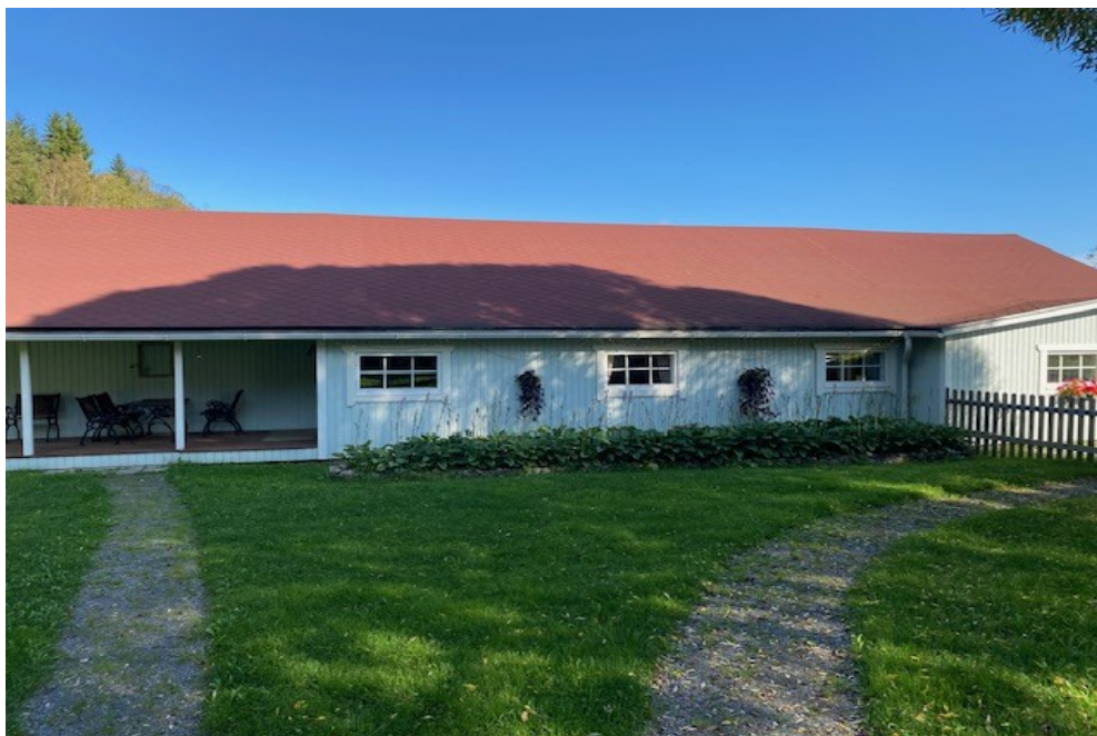
Kuva 20. Yleisilme julkisivun kunnosta. (Huusko 2023)
