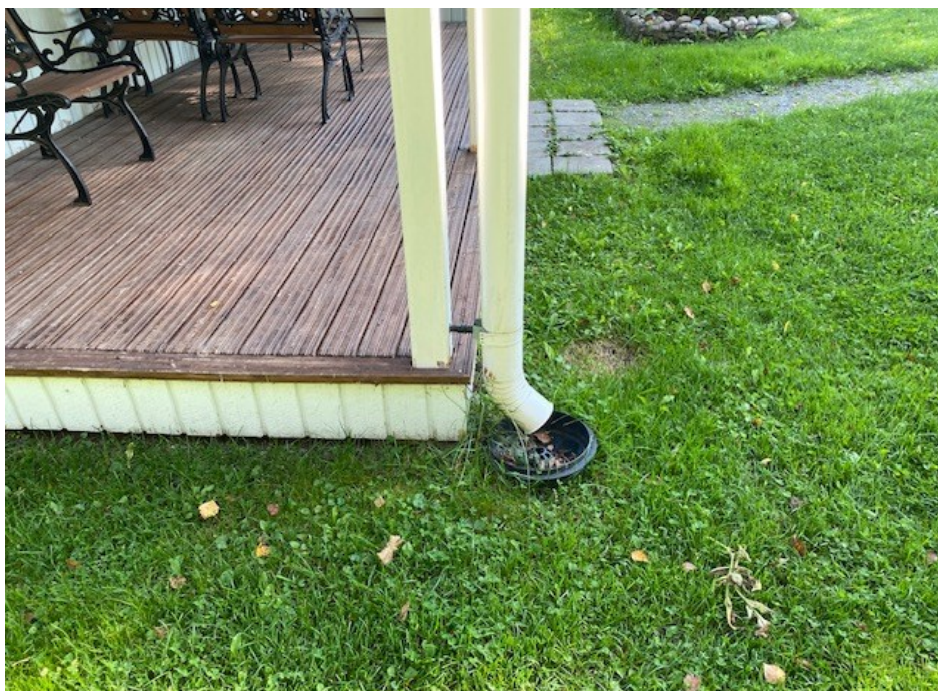
KUVA 7. Syökytorven sijainti kaivon yläpuolella. (Huusko 2023)
