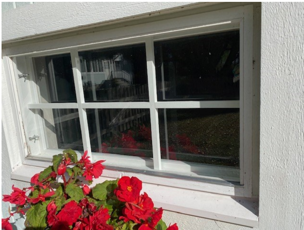
KUVA 26. Tippapellin ja karmin väliin pääsee vettä. (Huusko 2023)
