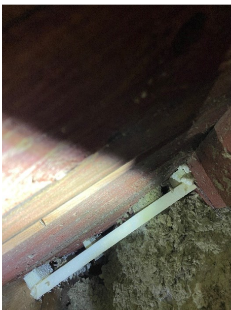
Kuva 19. Tuulenojaimessa puhallus villaa. (Huusko 2023)
