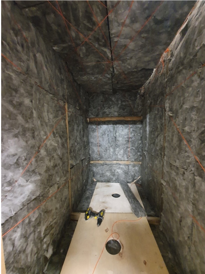
Kuva 6. Kammio täytettynä puoleksi sinne asennettavista vaimennusmateriaaleista.
