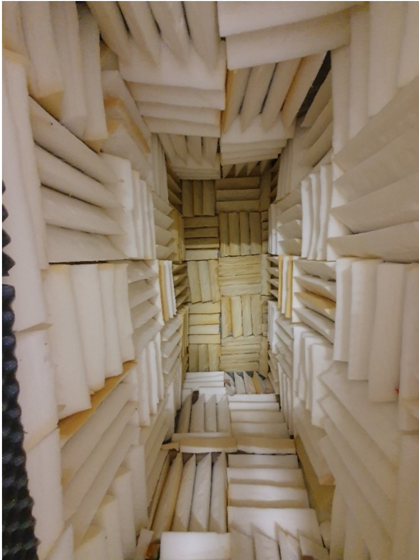
Kuva 7. Valmis kammio täytettynä vaimennusmateriaaleilla.
