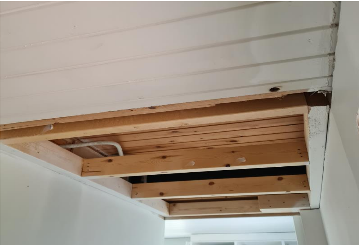
Kuva 9. Kuva käytävän alaslasku rakenteesta ennen ilmanvaihtoputkia (sisäinen tietolähde, 21.8.2023)
