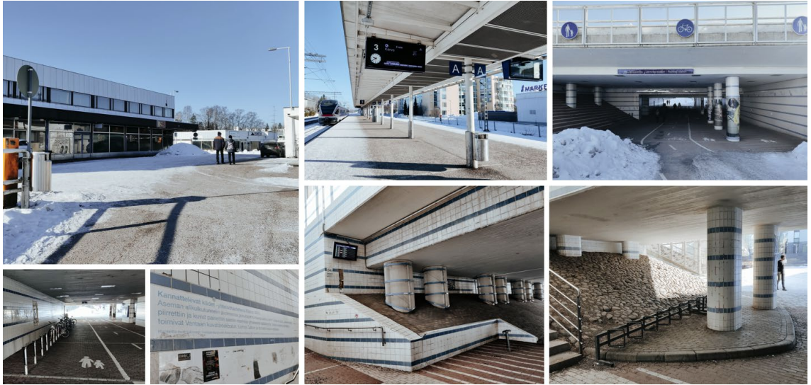
Kuva 4. Kuvassa on esitetty maastossa tehtyjä havaintoja: Aseman vanha ilme, kuluneet ja rikki menneet pinnat, asemaympäristön selkeys, pieniä yrityksiä tuoda esille Korson henkeä taiteen avulla, pyöräpysäköinnin huono laatu, kunnossapidon puutteet.
