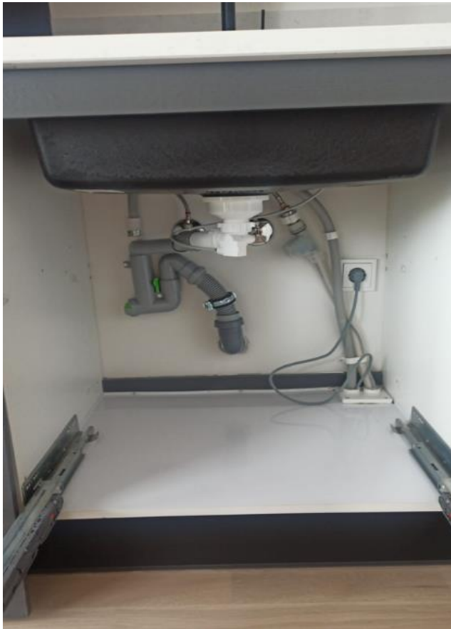
Kuva 21. Keittiön allaskaapin pohjalevy tiivistetty ja putkien asennuksessa on käytetty läpivientikappaleita.
