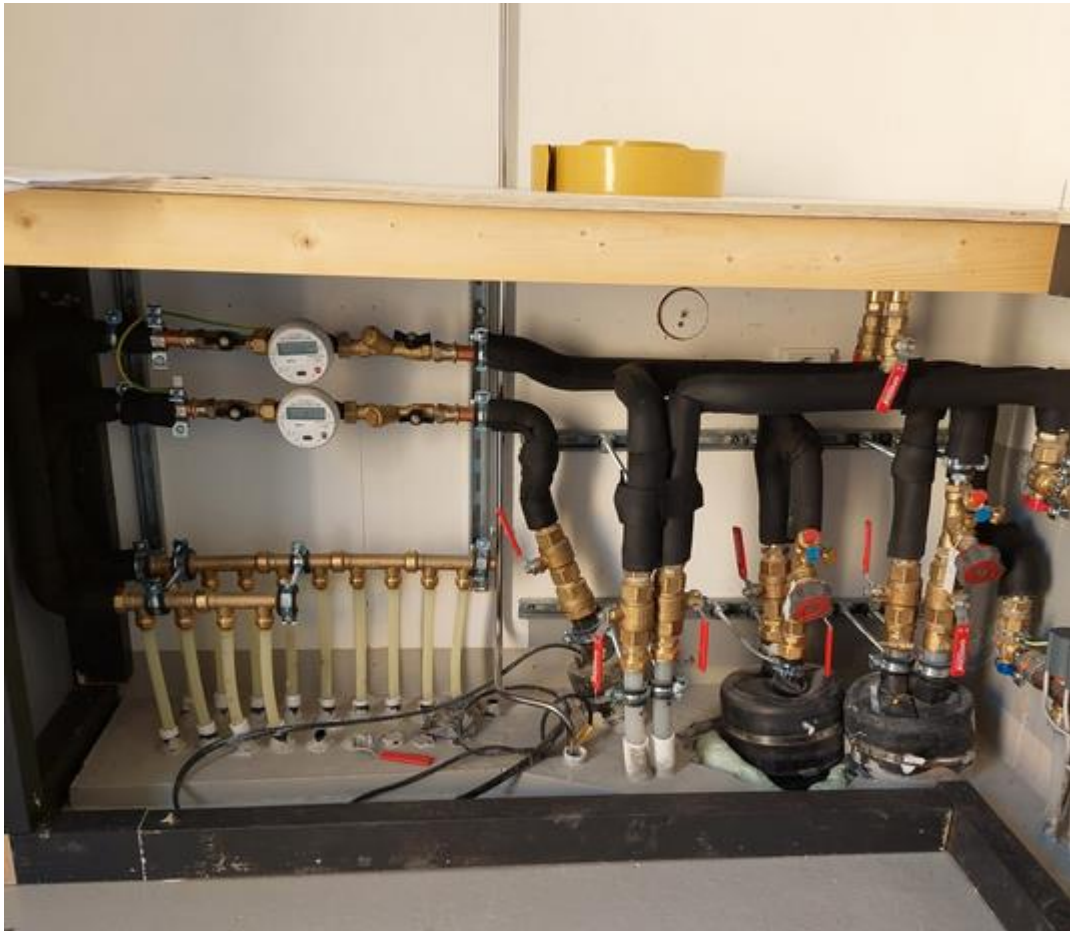
Kuva 20. Huoneistokohtaisten vesimittarien asennus.
