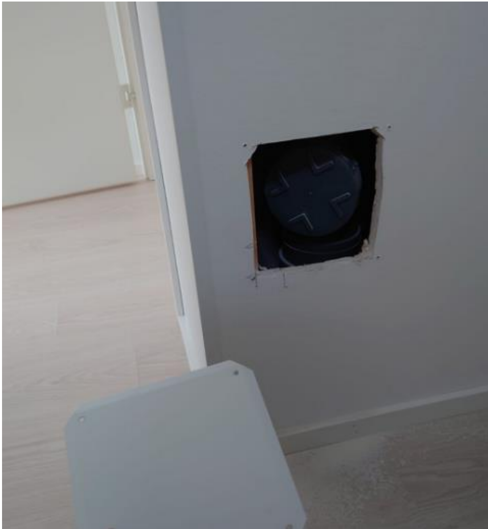
Kuva 9. Viemäriin puhdistusluukku.
