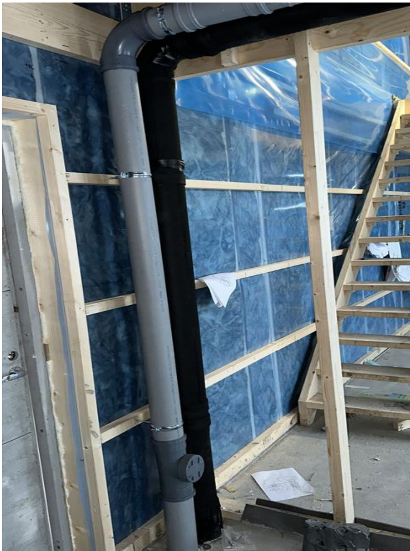
Kuva 10. Solukumilla eristetystä radonin poistoilmakanava.
