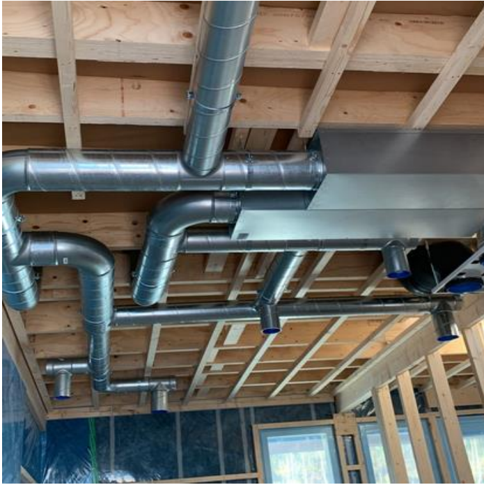
Kuva 17. Asennettu ilmanvaihtokanavisto tulpattuna ennen alakaton ja pääte-laitteiden asennusta.
