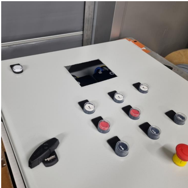
KUVA 6. Paneeli-PC:een asennukseen vaadittu aukko leikattuna
