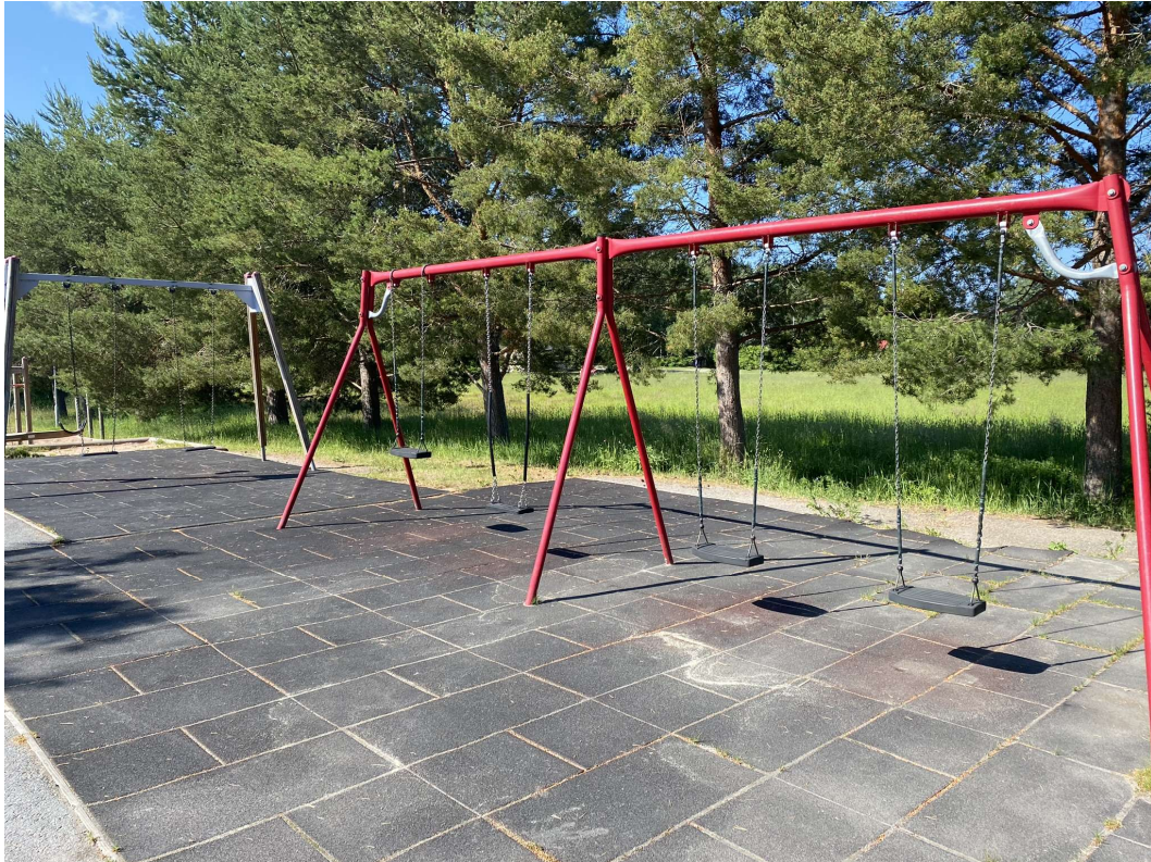
Kuva 2. Ahlaisten koulupihan keinujen alla turva-alustana turvalaatta
