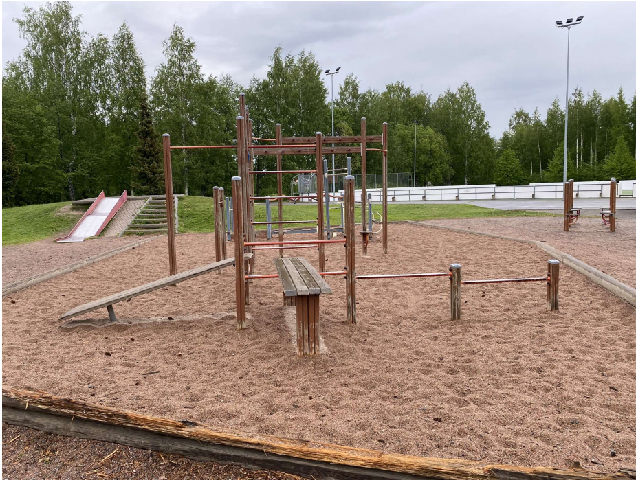
Kuva 1. Väinölään koulun kiipeilytelineen alla turva-alustana on hiekka.
