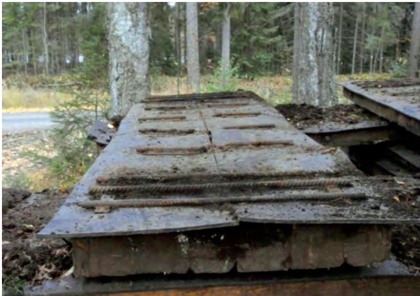
KUVA 20. Päällystetty ajosisilta (Kuva Kati Kontinen).
