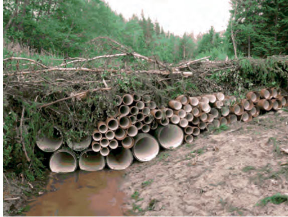
KUVA 3. Ajouran vahvistamista Latviassa (Balodis 2012).
