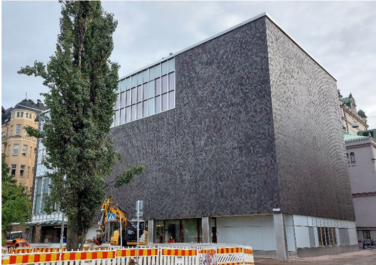
Kuva 6, Suomen Kansallisteatterin 1950-luvulla rakennettu osa
