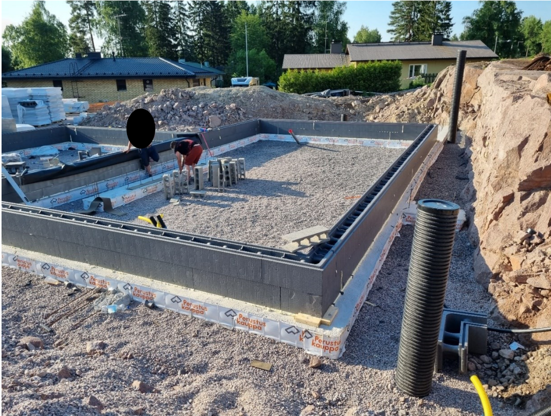
Kuva 5 Ensimmäiset harkkokerrokset asennettu ja tiivistetty perustuksiin.
