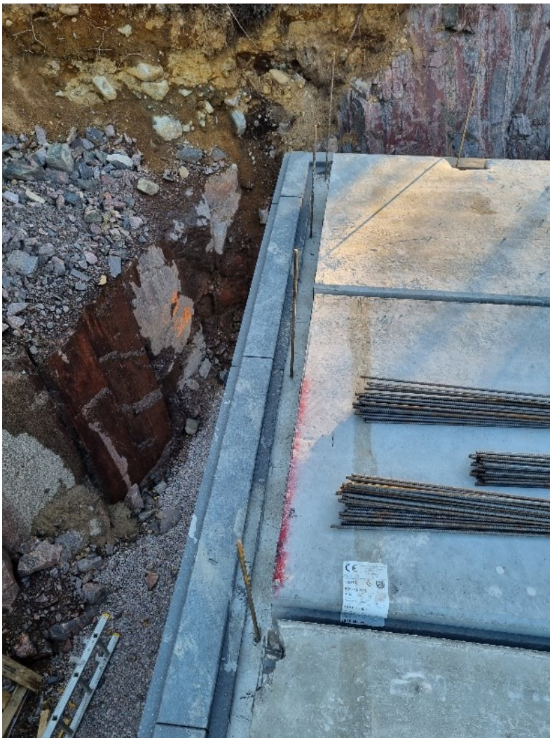
Kuva 11 Ontelolaatat asennettu runkobetonin päälle.
