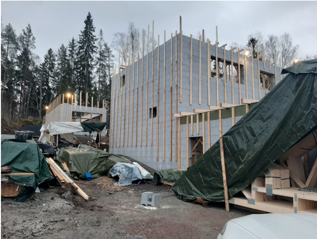
Kuva 20 Puujulkisivun koolauslaudat asennettuna.
