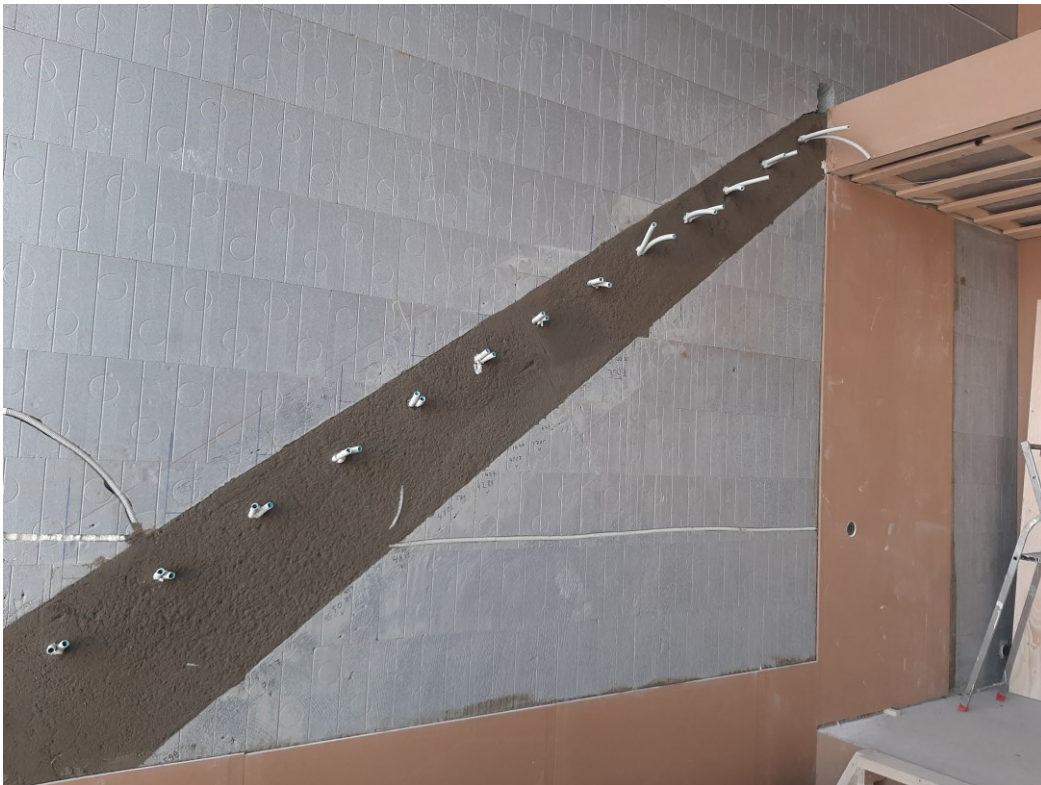
Kuva 17 Seinien levytys aloitettu.
