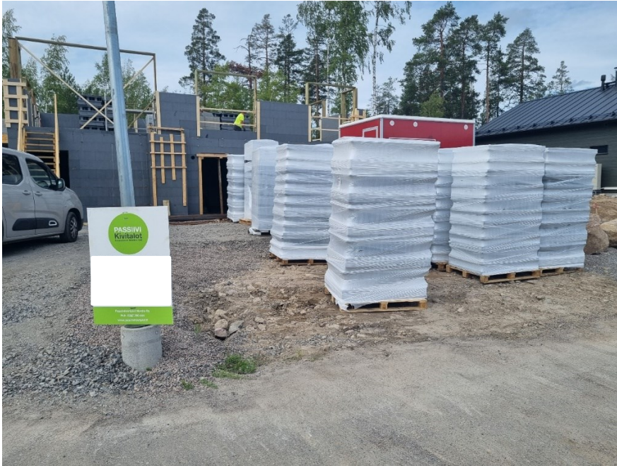
Kuva 3 Kivisydän lämpöharkkojen vaatima tila työmaalla.
