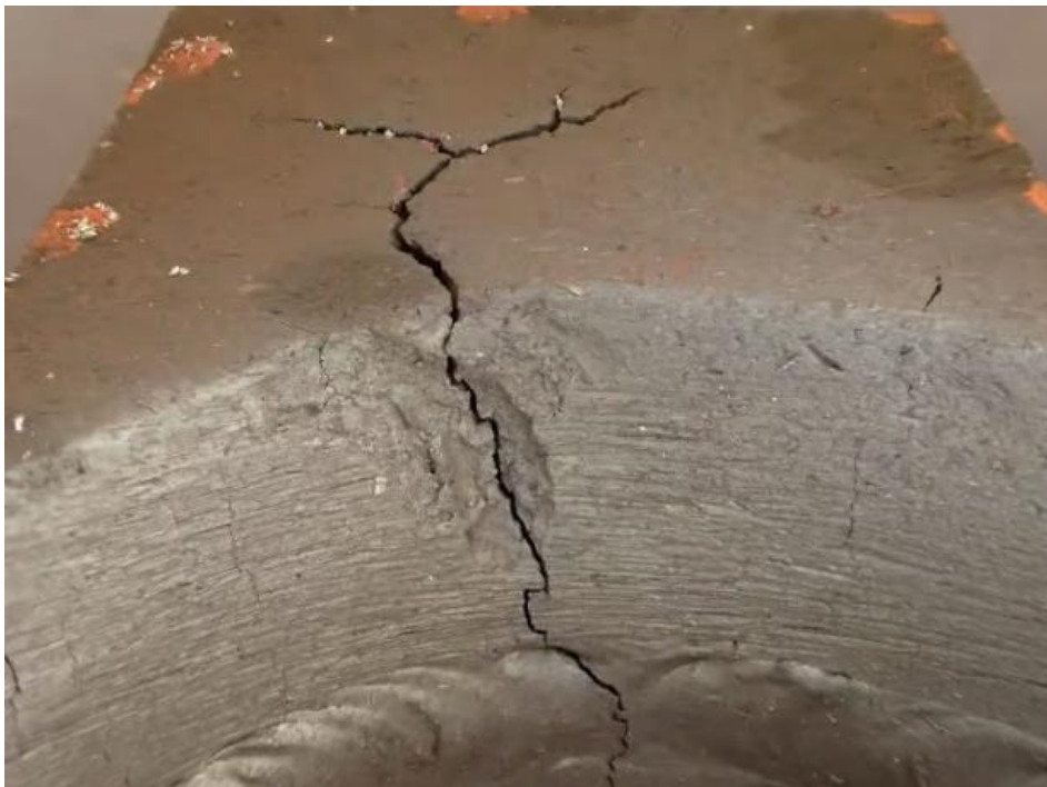
Kuva 5. Jännitys korroosio. (US CORROSION SERVICES, 2023)
