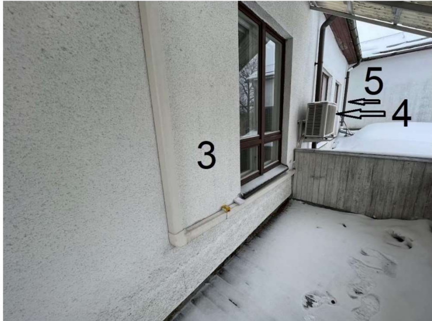
Kuva 9. Koepalojen 3, 4 (Ilmalämpöpumpun oikealta puolelta) ja 5 (Seinän nurkalta) sijainnit rakennuksen toisesta kerroksesta itäiseltä parvekkeelta.
