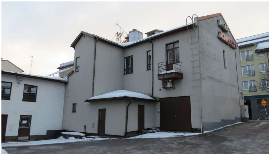
Kuva 1. Yleiskuva kohteesta sisäpihan puolelta
