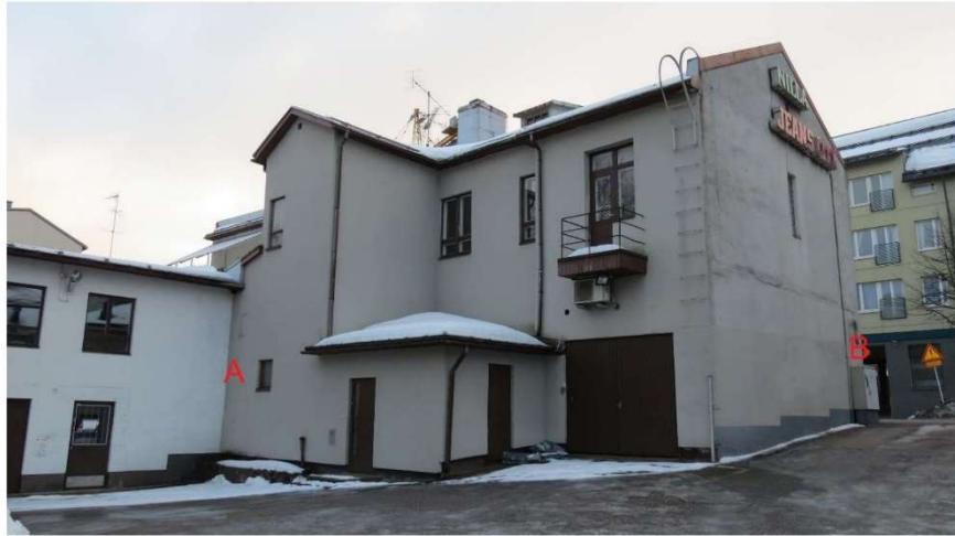
Kuva 10. Pintakosteusmittauksen kierto rakennuksen sisäpihalla pisteestä A alkaen pisteeseen B.
