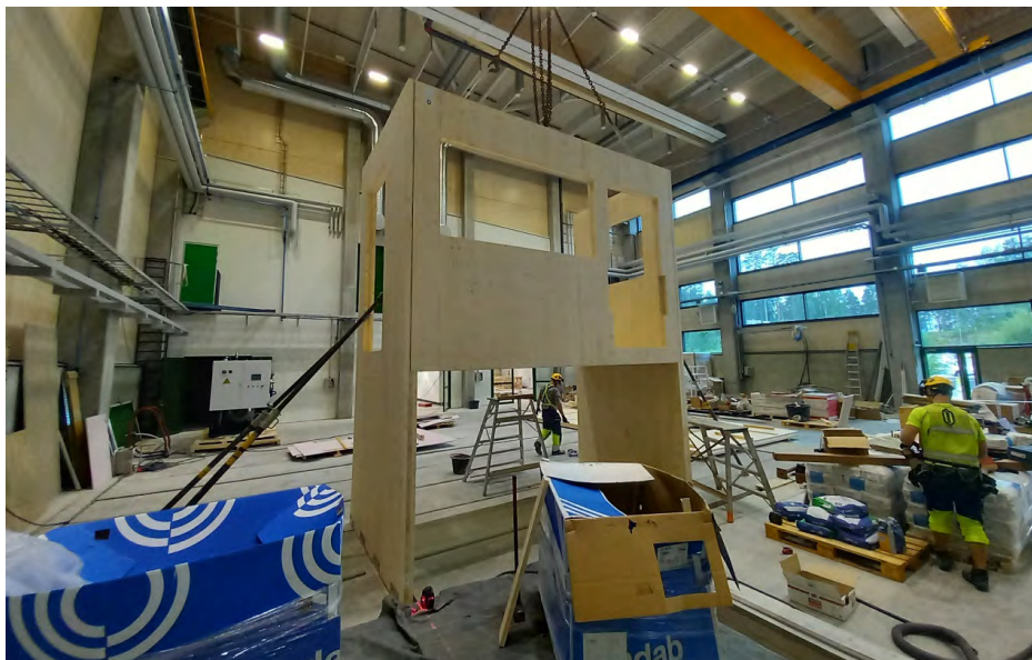
KUVA 12. Pidemmän sivun seinän asennus (kuva Niko Kinnunen).
