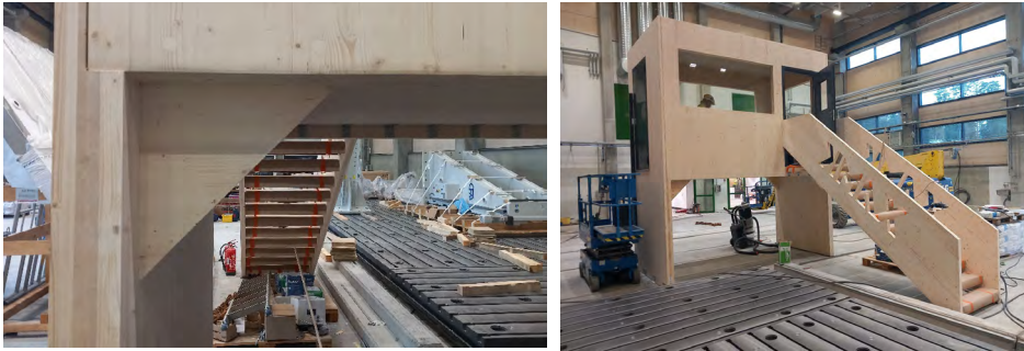
KUVA 14. Valvomoon jälkepäin lisätty tuenta (kuva Niko Kinnunen).
