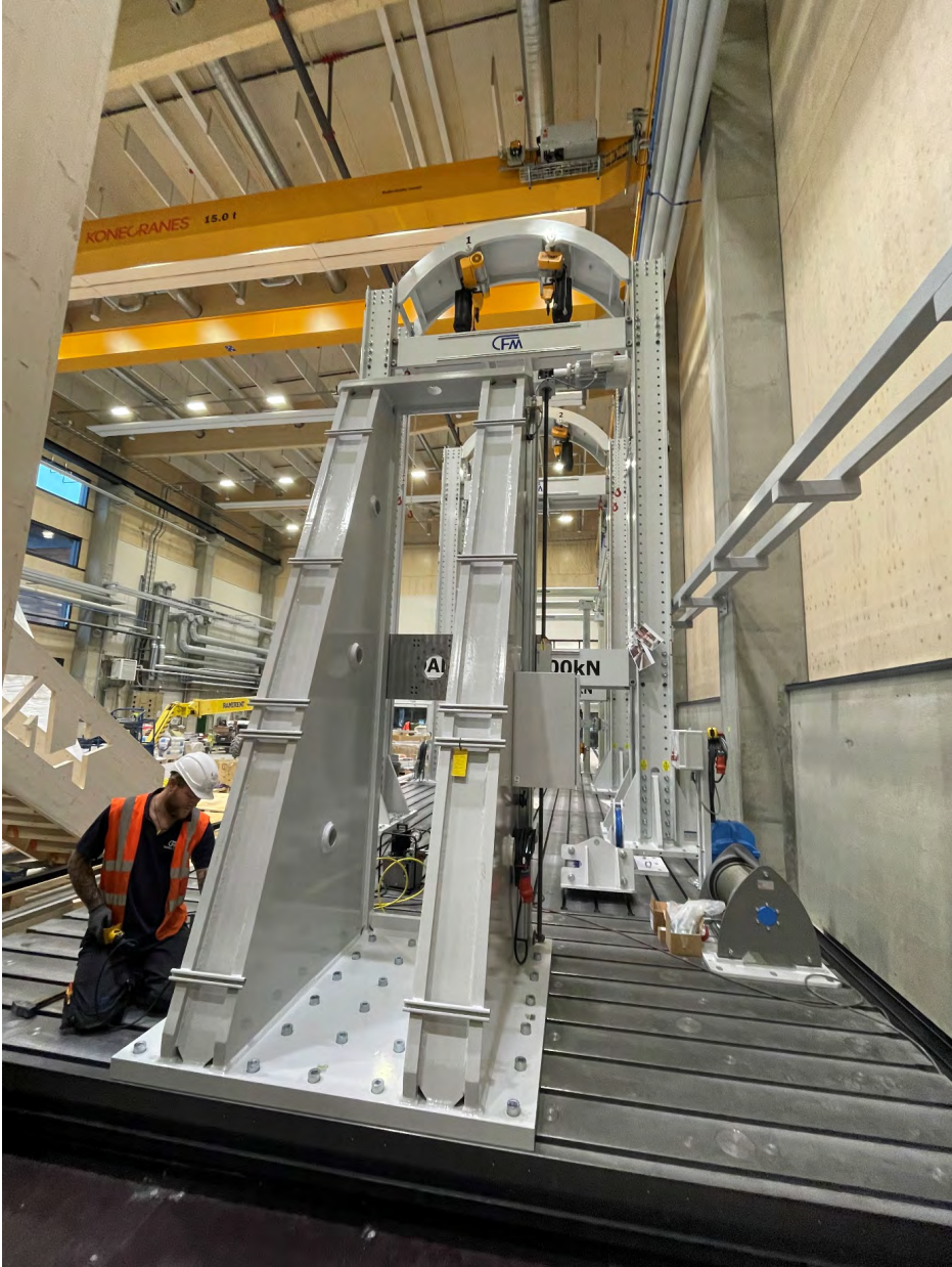
KUVA 2. Xamkin Savonlinnan teollisen puurakentamisen laboratorion kuormitustestauslaitteiston teräsrakenteet asennusvaiheessa (kuva Lasse Pulkkinen).
