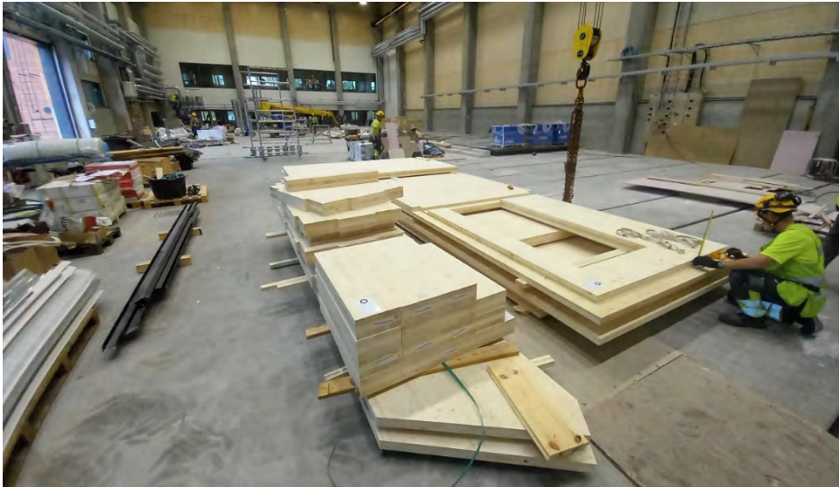
KUVA 8. CLT-elementit odottamassa asennusta (kuva Niko Kinnunen).
