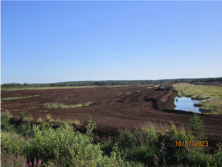
KUVA 1. Ennallistettavaa suonpohjaa tasoitetaan ja siihen muotoillaan jäniteitä ennen suokasvillisuuden levittämistä (kuva Pasi Pakarinen).
