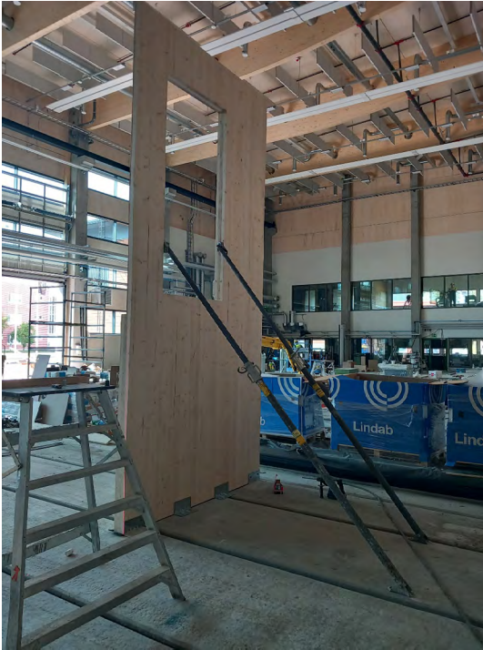
KUVA 10. Elementtien työnaikainen tuenta elementtitukien avulla (kuva Niko Kinnunen).
