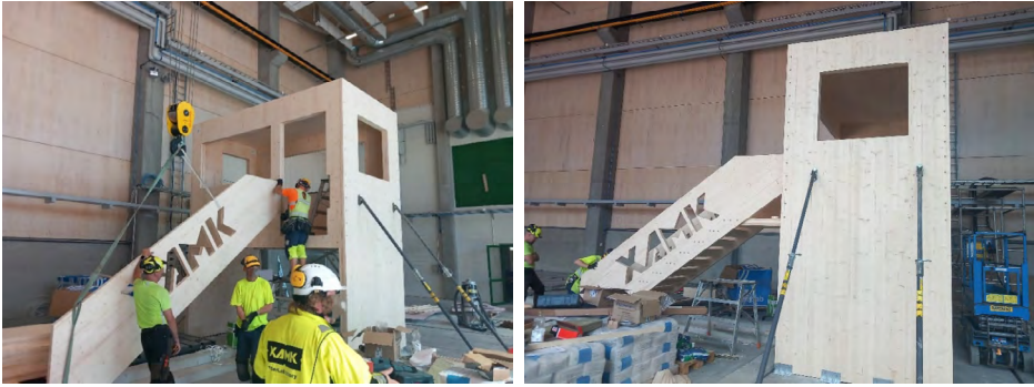
KUVA 13. Portaiden asennus (kuva Niko Kinnunen).
