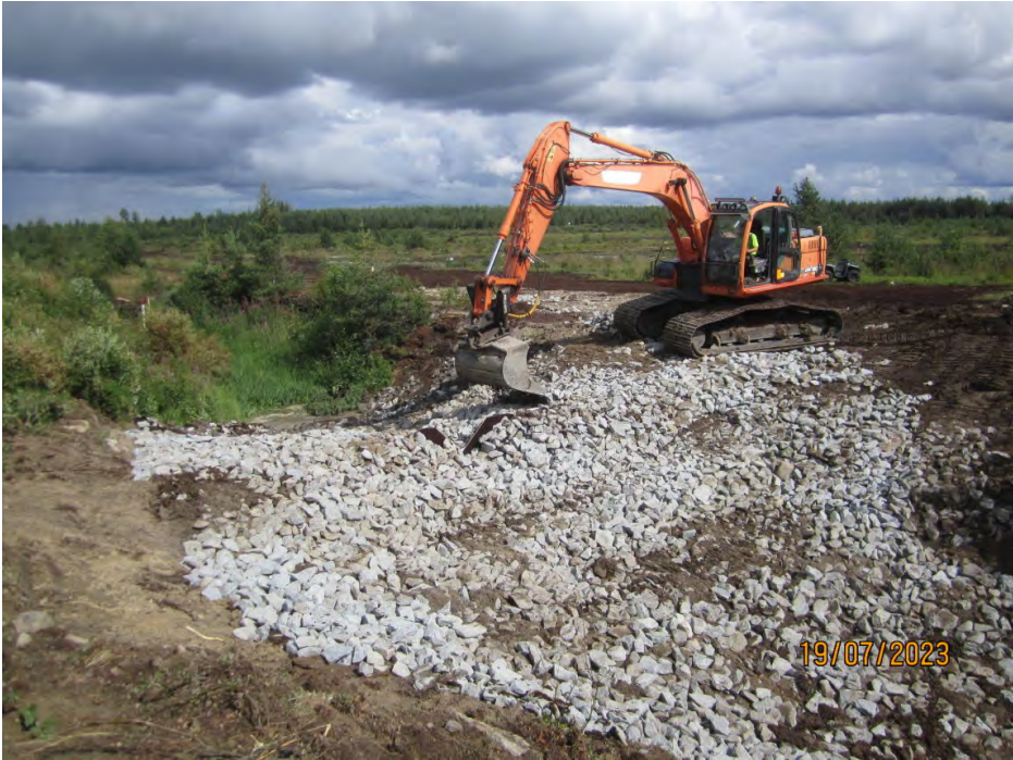
KUVA 3. Tuotantoalueen valtaojiin rakennetaan patoja, joiden avulla turvetuotantoalueelle pidätetään vettä (kuva Pasi Pakarinen).
