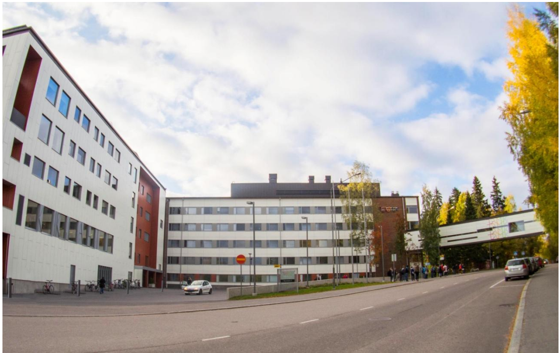
KUVA 1. Valmis G- ja H-talo sekä yhdyskäytävä
