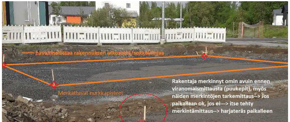
Kuvio 39. Rakennuspaikan merkintä maastoon, missä myös rakennuttaja on merkinnyt nurkkapisteet
