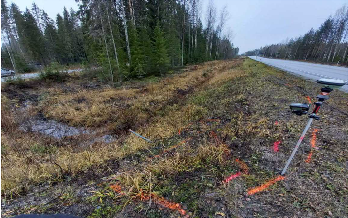
Kuvio 77. Kaapelinnäyttö pohjatutkimuspisteiden merkintämittauksen yhteydessä Konginkankaalla Keski-Suomessa. Punainen ja oranssi ovat merkittyjä johtolinjoja, jotka on näytön ohessa kartoitettu paikoin GNSS-mittauksena
