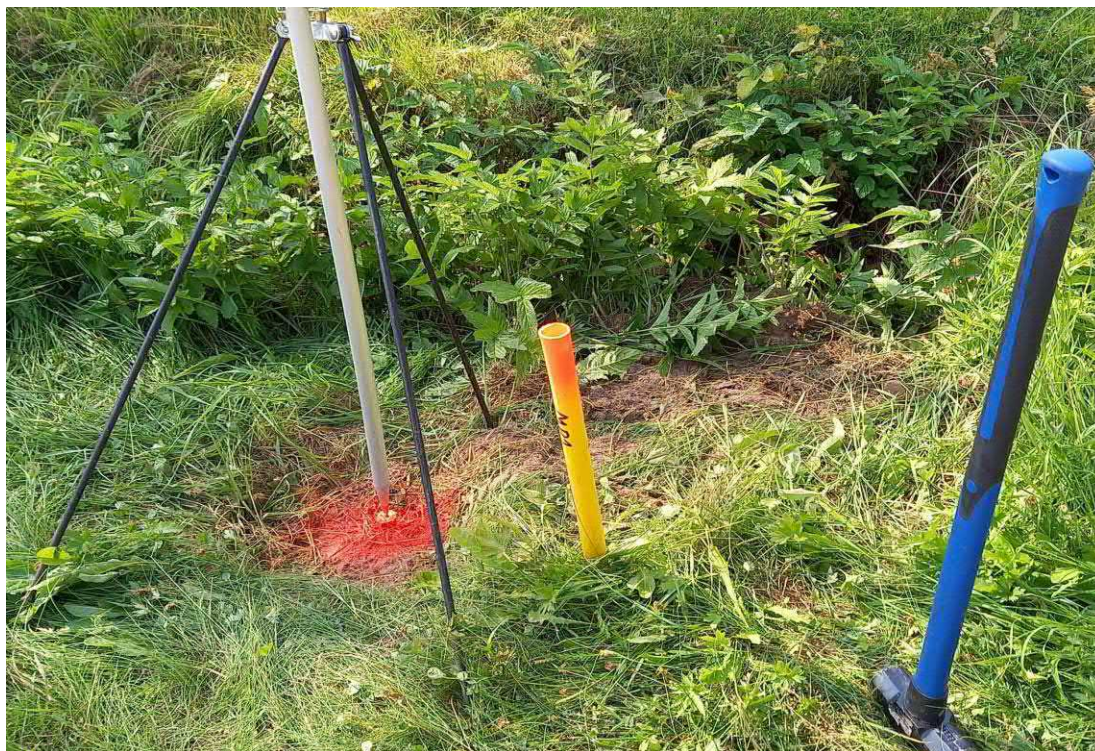
Kuvio 60. E5-luokan mittauspisteiden asennustyöt ja alustavat mittaukset
