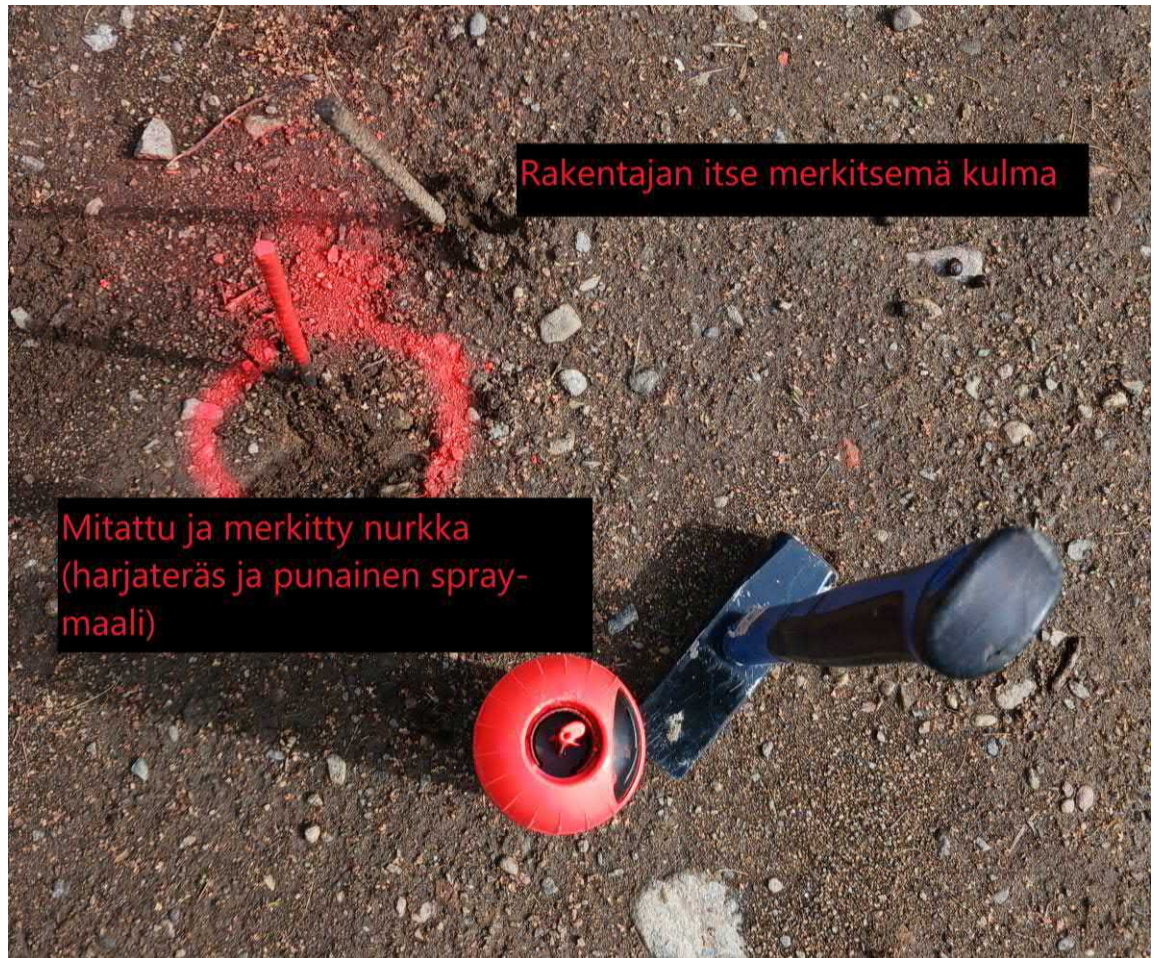
Kuvio 41. Rakennuspaikan merkintää maastoon välineineen
