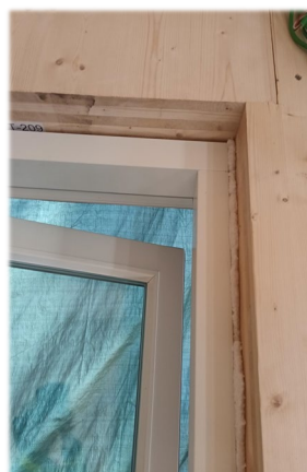
Kuva 30. 2krs. oven tiivistys
