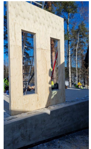
Kuva 7. Eteläseinän LVL- elementti
