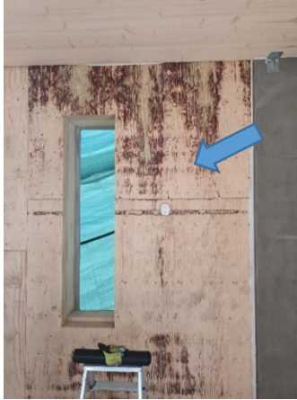
Kuva 43. Milesight EM300 1krs. pohjoisseinä.
