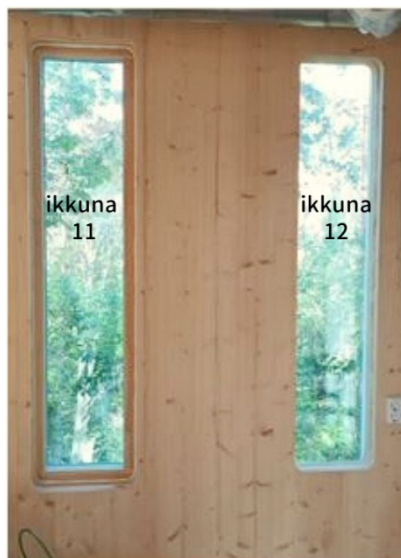
Kuva 26. 2krs. Ikkunat 11 ja 12
