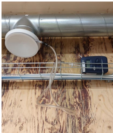
Kuva 63. Näytteenkeräys tuloilman kanavasta
