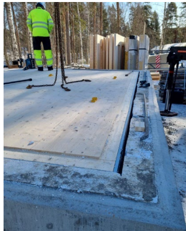
Kuva 6. AP elementit asennettuna.
