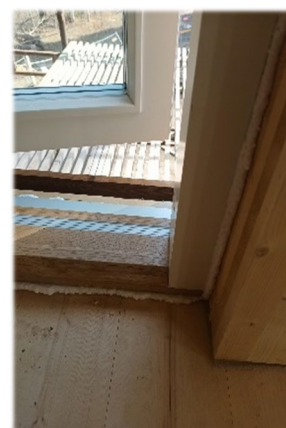
Kuva 31. 2krs. Elastinen PU-vaaho ovessa.
