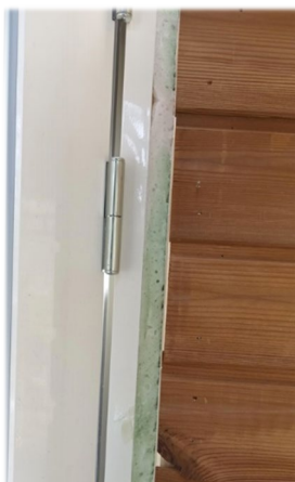
Kuva 29. 1krs. oven tiivistys. PU-vaaho leikattu.
