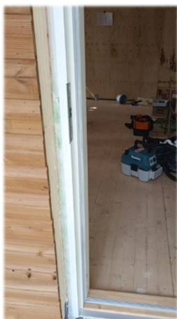
Kuva 28. 1krs. oven tiivistys
