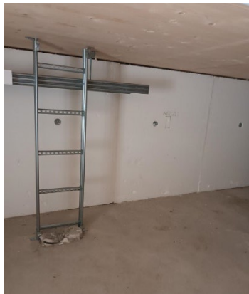
Kuva 22. Testitalon ryömintätila, eteläseinä.
