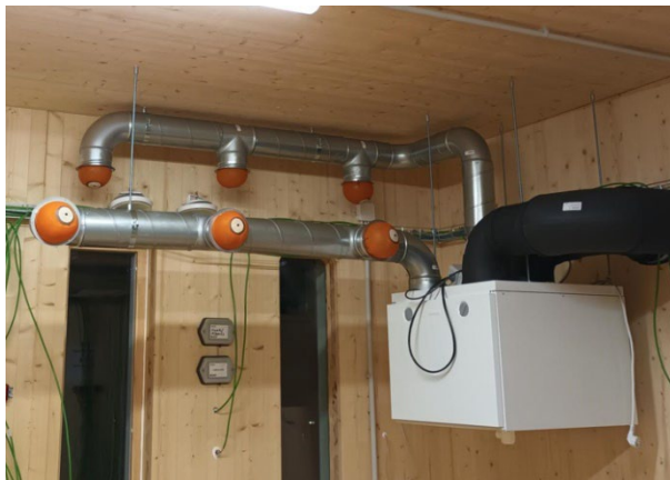
Kuva 59. Tulo- ja poistoilmaventtiilien tiivistys
