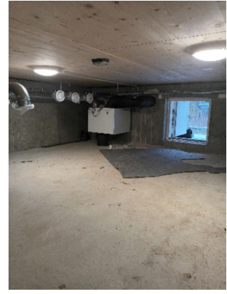
Kuva 24. Ryömintätilan IV-kone.
