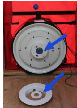
Kuva 48. 1krs. Paine- nekoelaitteisto, sul- kurenkaat. Mittaus
