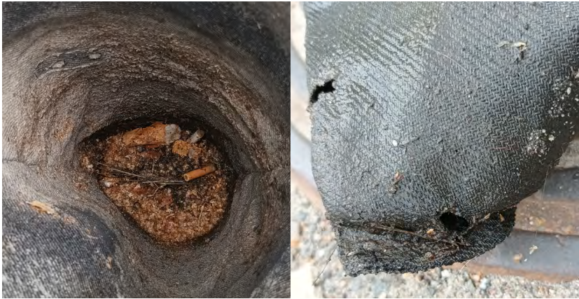
Kuva 7. Ekopisteen suodattimeen päätyneet palavat tupakat sulattivat suodattimiin reikiä (kuva Niina Laurila).
