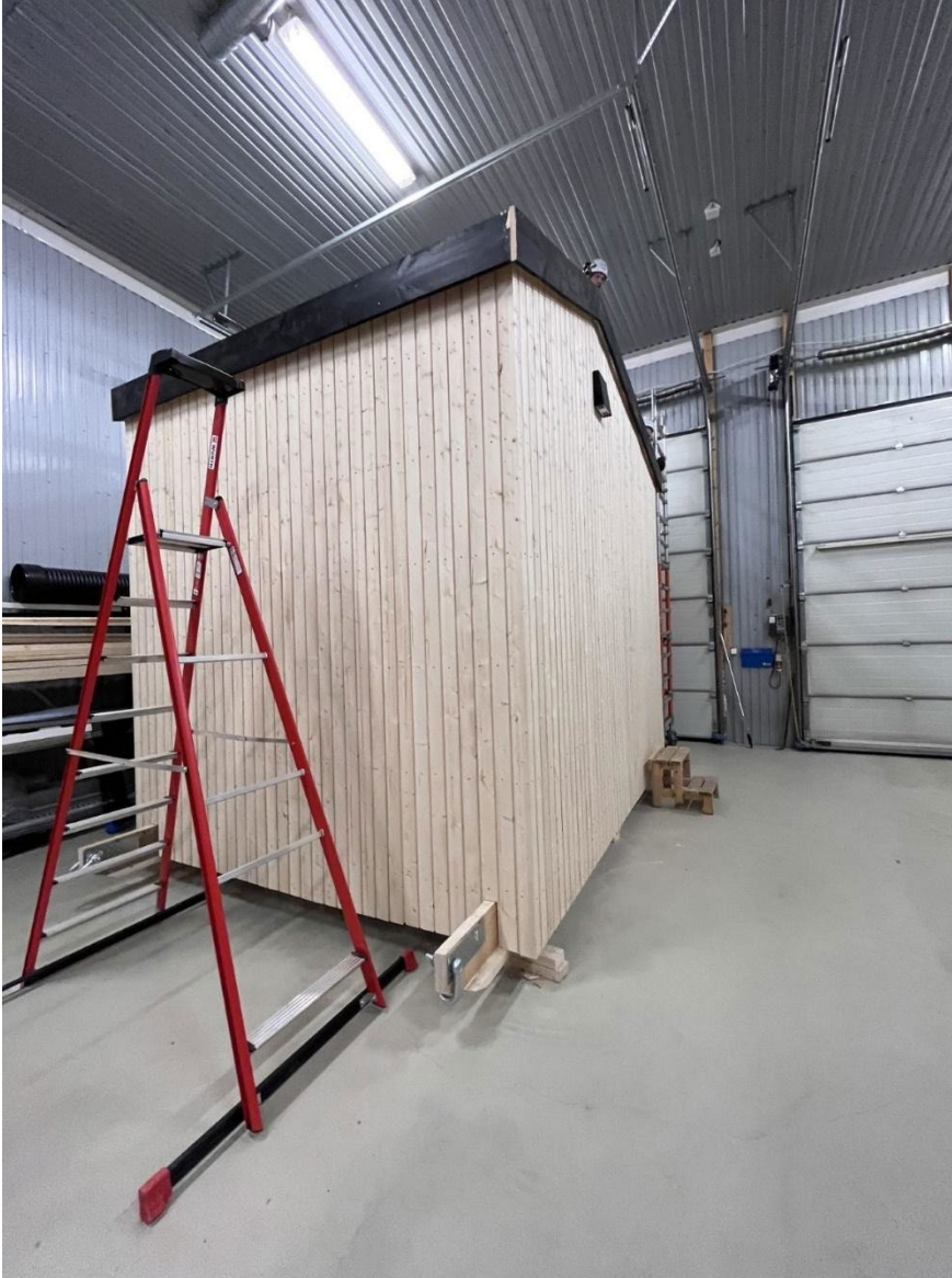
Kuva 6. Rakentaminen suoritettiin pitkälti hallissa. Kuva: Niko Pernu
