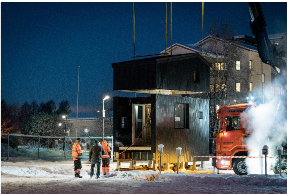
Kuva 6. CoolBox-mikrorakennuksen asentaminen tontille TP-600 perustuspilareiden päälle. Kuva: Niko Pernu
