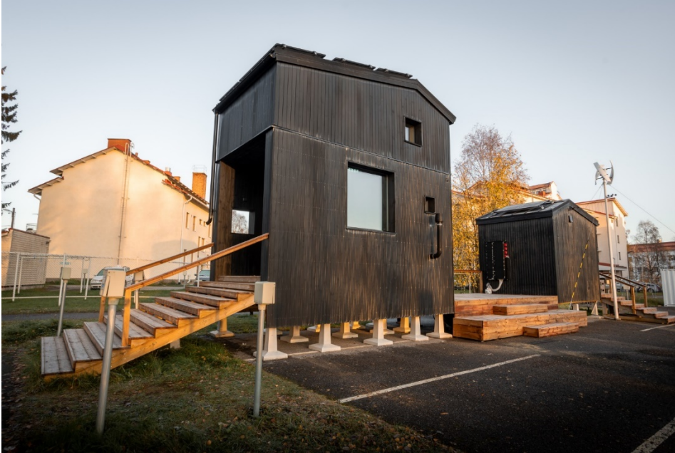
Kuva 7. CoolBox-mikrorakennus ulkoapäin kuvattuna. Kuva: Niko Pernu
