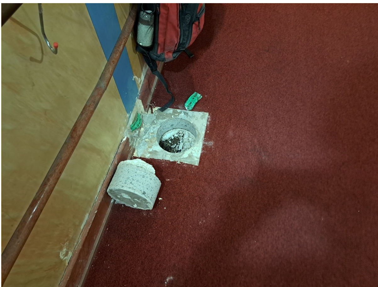
Kuva 21. Pintavaluun porattiin tarkastusreikä, mistä päästiin näkemään eristetila sekä ottamaan näytepalat
