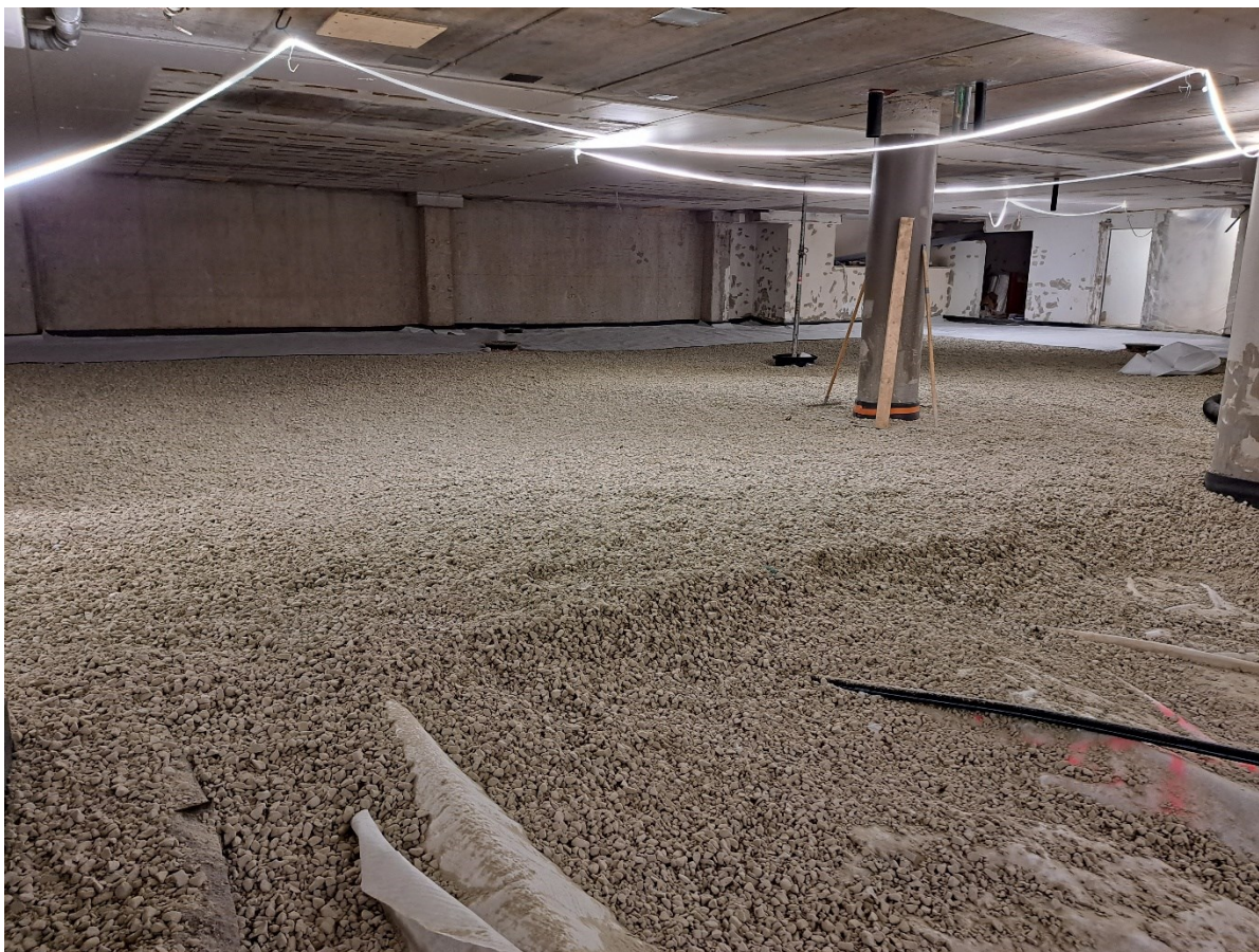
Kuva 1. Vaahtolasilla korvattu alapohjan eristekerros
