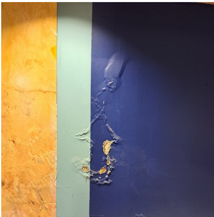
Kuva 17. Maali rapistunut betoniseinän sauma-alueella
