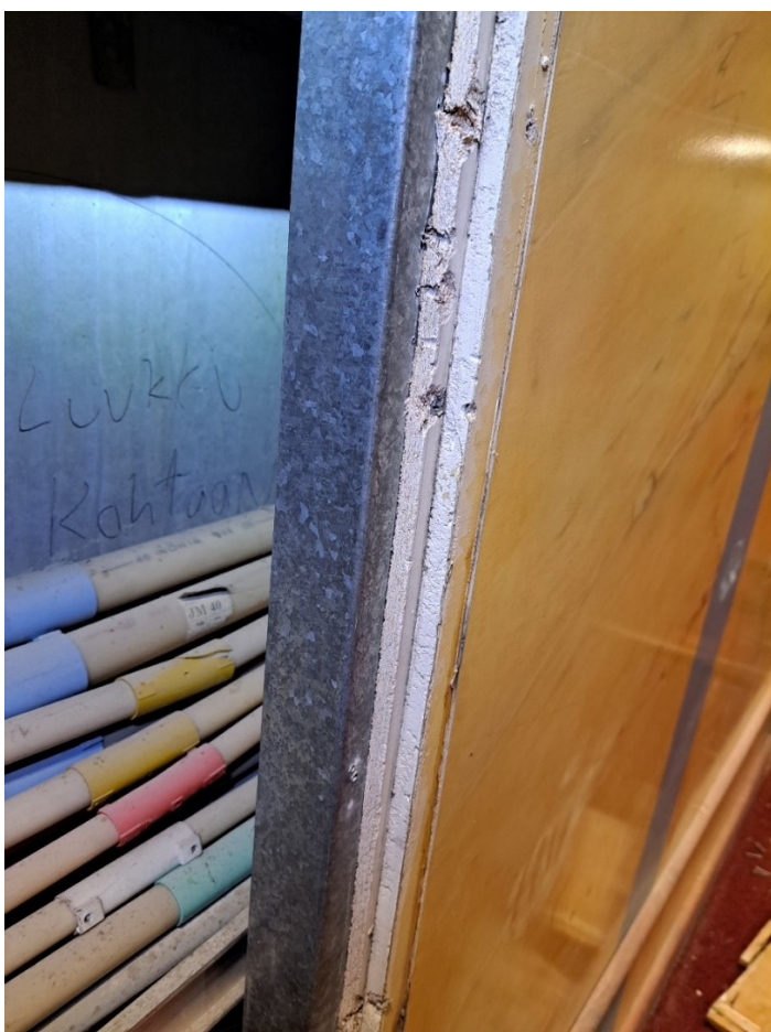
Kuva 18. Rankarunkoisen seinän kerrokset
