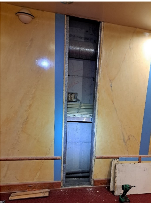
Kuva 15. Rakenneavaus tunnelin rankarunkoisessa seinässä
