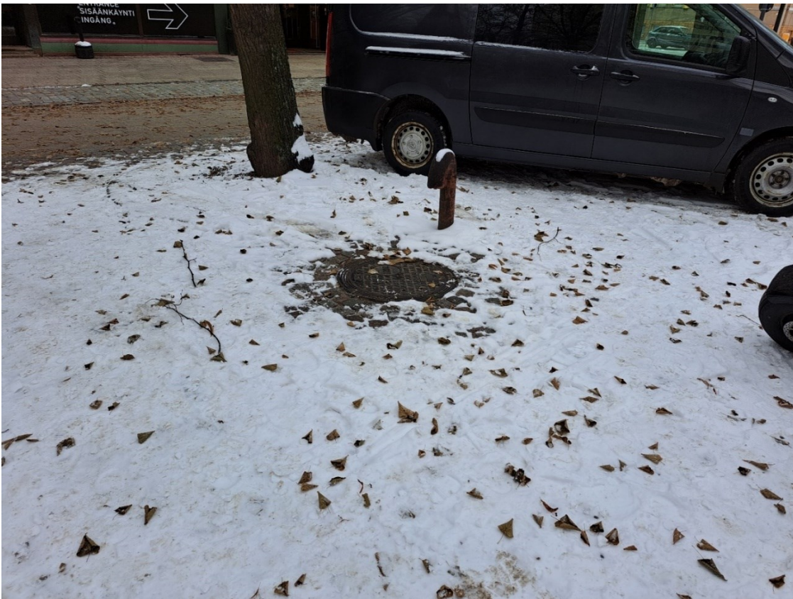
Kuva 12. Pumppukaivon sijainti kadulla
