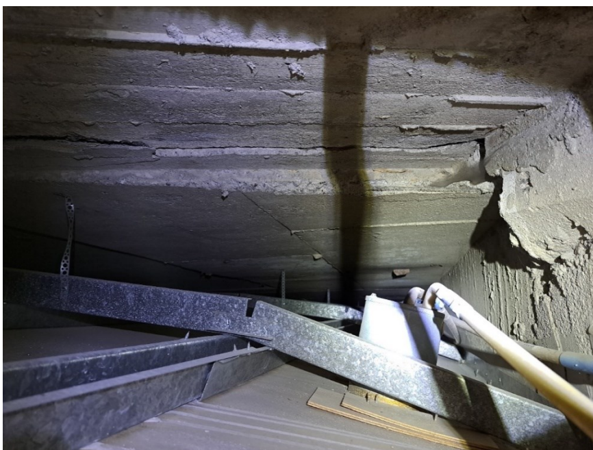
Kuva 20. Alakaton yläpuoli näyttää kuivalta
