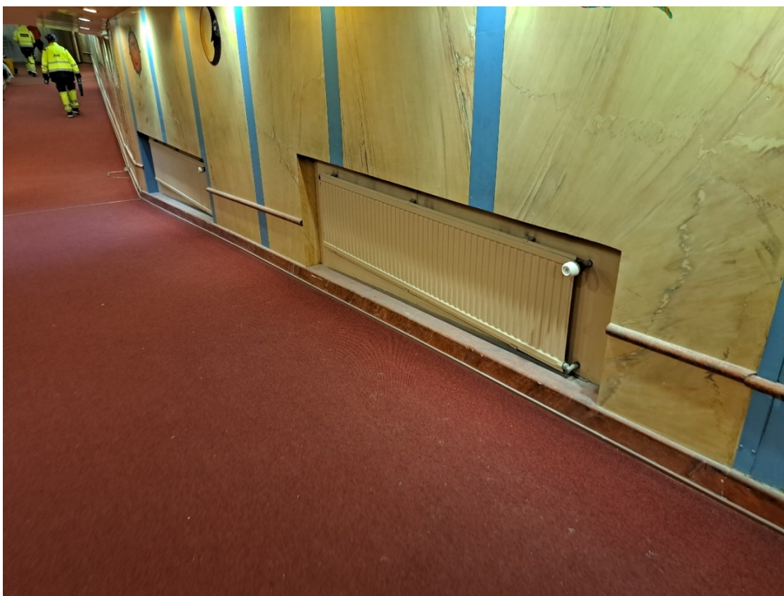
Kuva 6. Tunnelin lämpöpatterit
