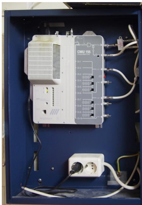
KUVA 9. Antennivahvistin (Valokuva Ville Roininen.)
