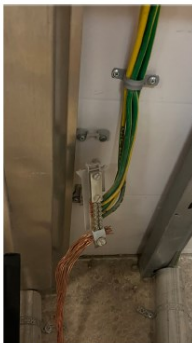
Kuva 1. Rikkinäinen/irtonainen maadoituskisko.
