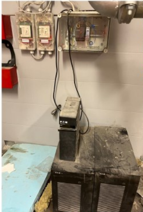
Kuva 19. UPS-laitteisto huoltamatta.
