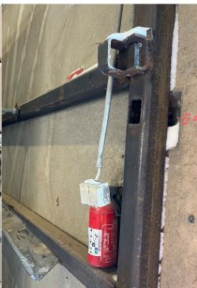
Kuva 12. Irrallaan oleva pistorasia.
