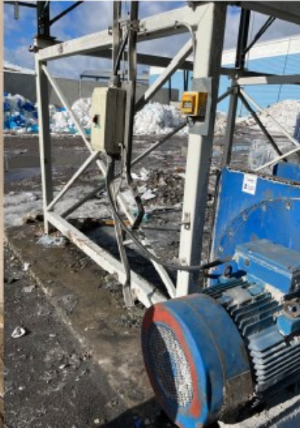
Kuva 20. Moottorin syöttökaapeli.
