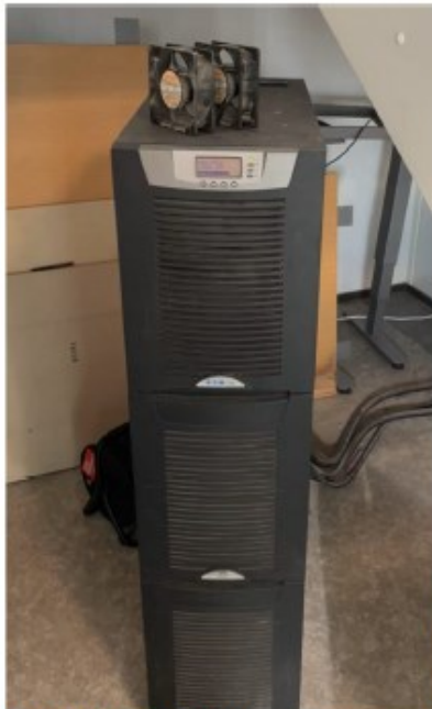
Kuva 5. Huoltamaton UPS
