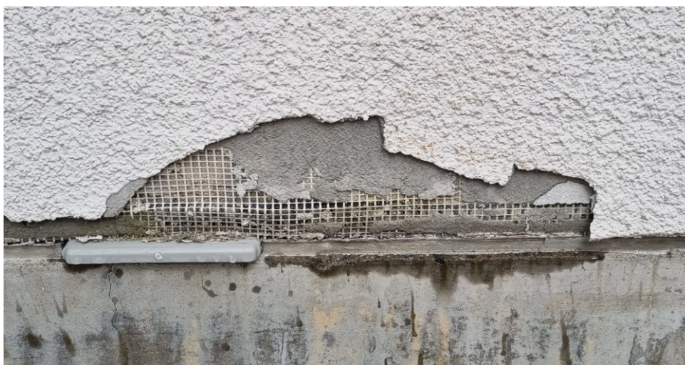
Kuva 45. Kohde 1.sokkelisauman toteutus (virheellinen)
