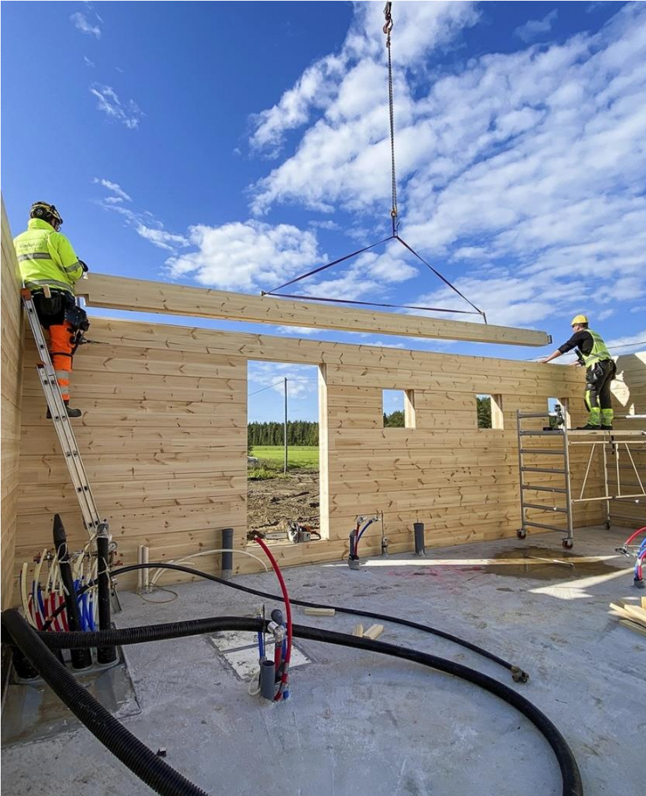
Kuva 2. Hirsitalon pystytys (Vieskakodit, i.a.).
