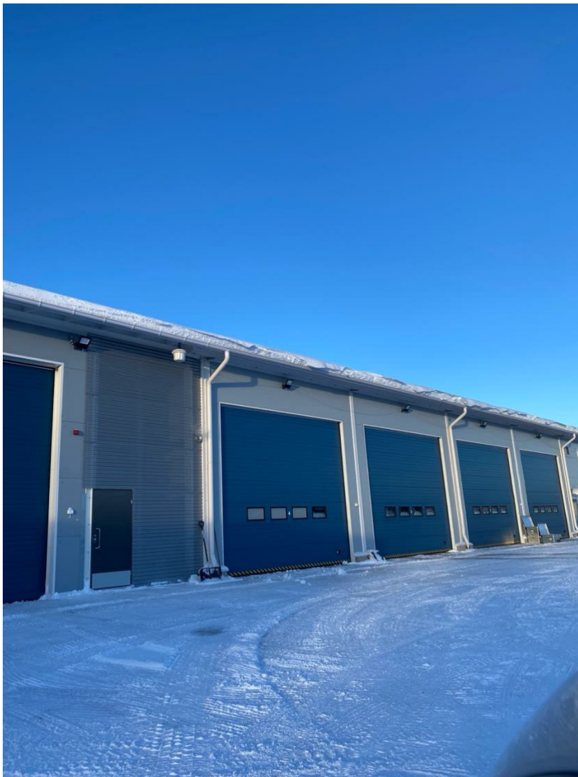
Kuvio 9. Hallirakennukset ovat vain yritysten käytössä ja ulkopuolisilta sinne on pääsy kielletty (Stoor 2024)
