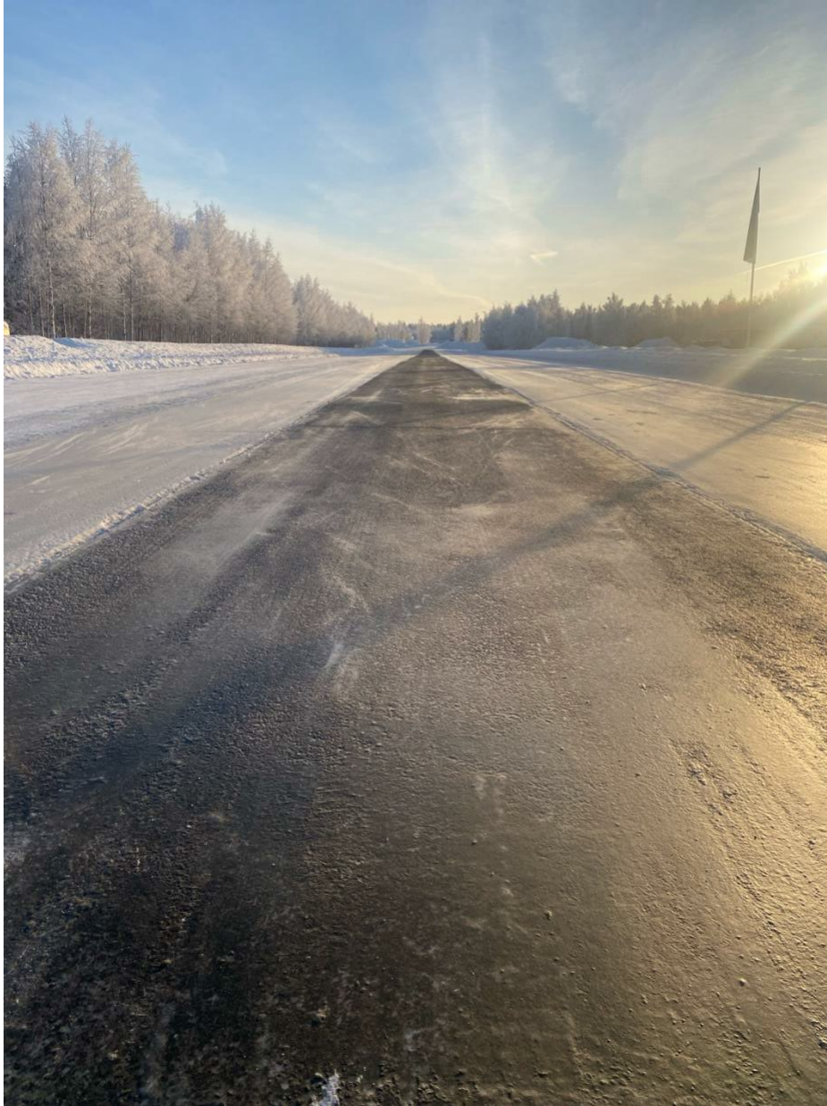
Kuvio 6. Asfalttialueen alku jäädytysalueen jälkeen, jossa suoritetaan jarrutustestejä (Stoor 2024)
