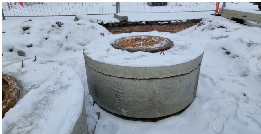
Kuva: Maaventiilikaivo ennen kaivannon lopullista täyttöö
