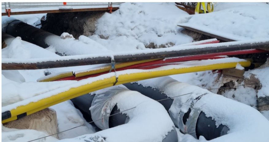
Kuva: Kaukolämpökaivannon ylittävät kaapelit
