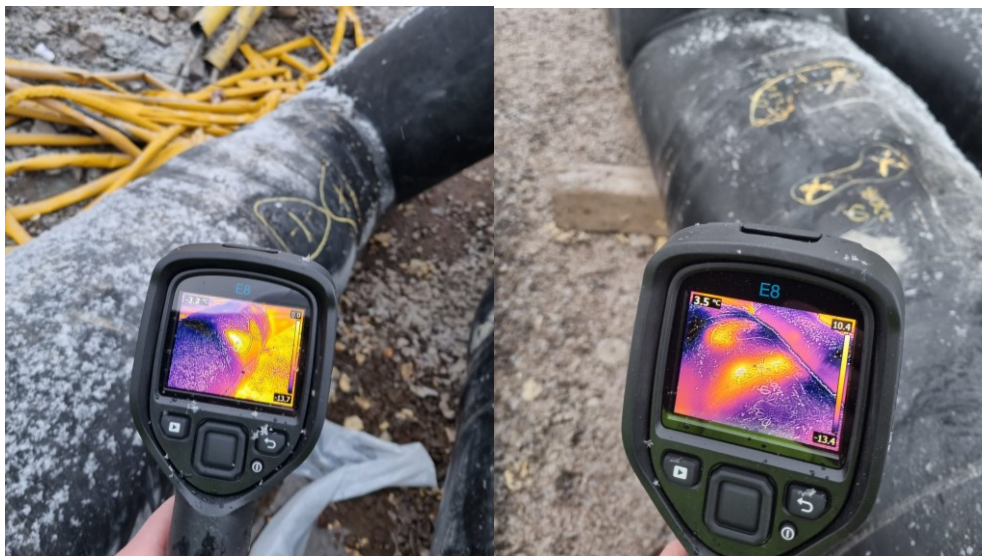
Kuvat: Vaahdotuksien tarkastukset lämpökameralla
