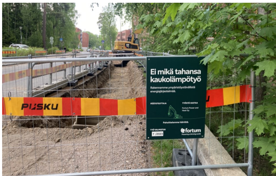
Kuva: Työmaakyltti suoja-aidassa ja raskassuojat kaivannon liikenteen puolella
