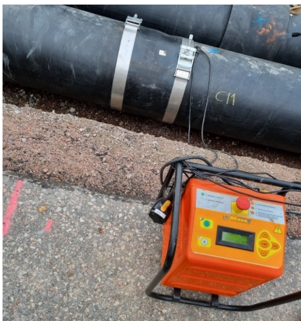
Kuva: Sähkömuhvi ja sähköhitsauksen osat
