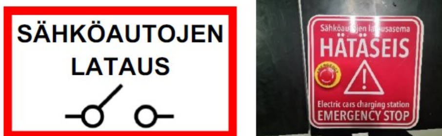
Kuva 4. Virransyötön katkaisupaikan opasteet [10].
