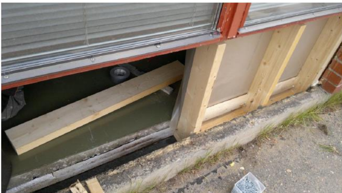
Kuva 4. Seinän vaiheittainen rakentaminen aloitettu
