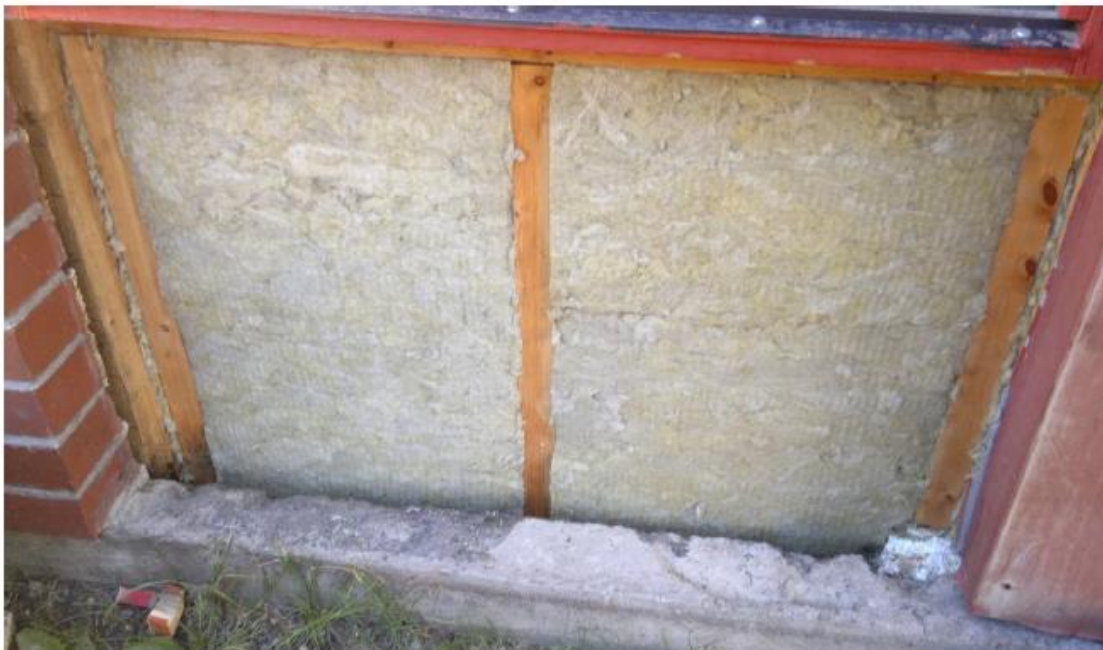
Kuva 2. 100 mm villa asennettu
