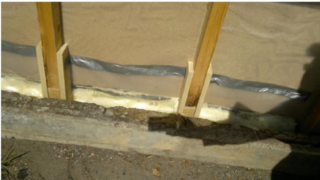
Kuva 4. Kengitetyt runkotolpat ja korjattu höyrysulku
