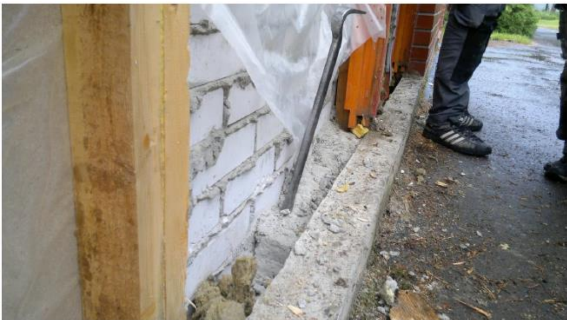
Kuva 2. Valesokkelin pohjalla muurauslaastia
