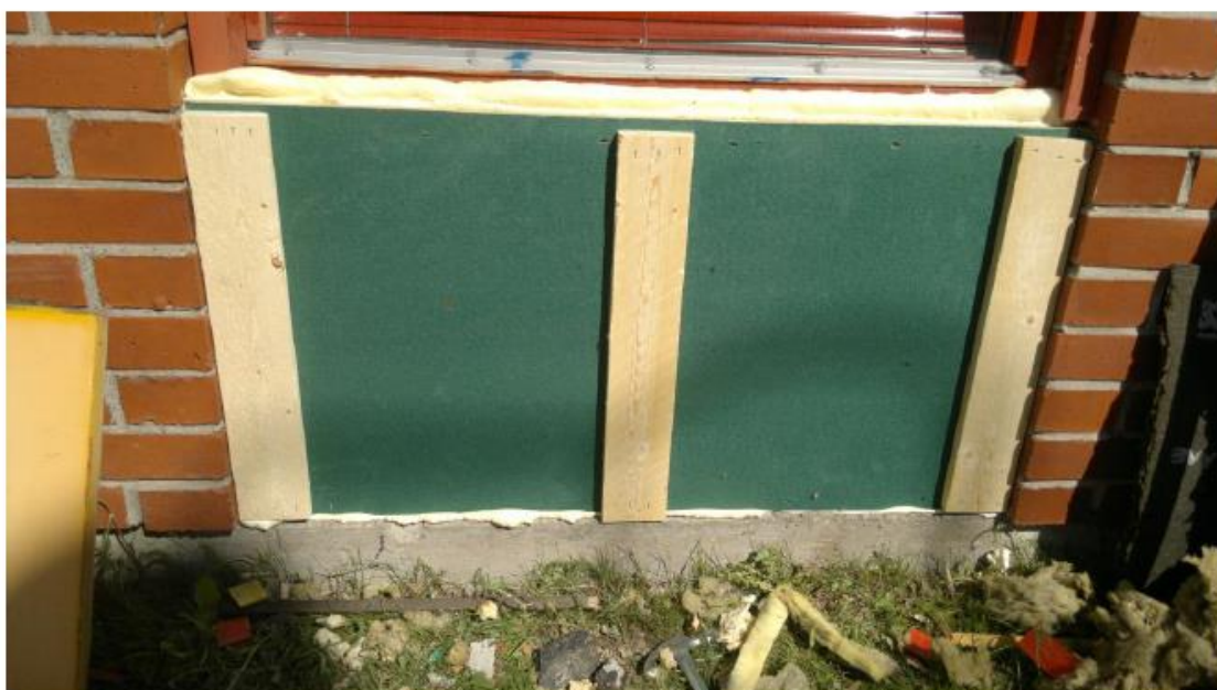
Kuva 4. 150 mm villa asennettu ja sen päälle kiinnitetty puukuitulevy ja lautakoolaus
