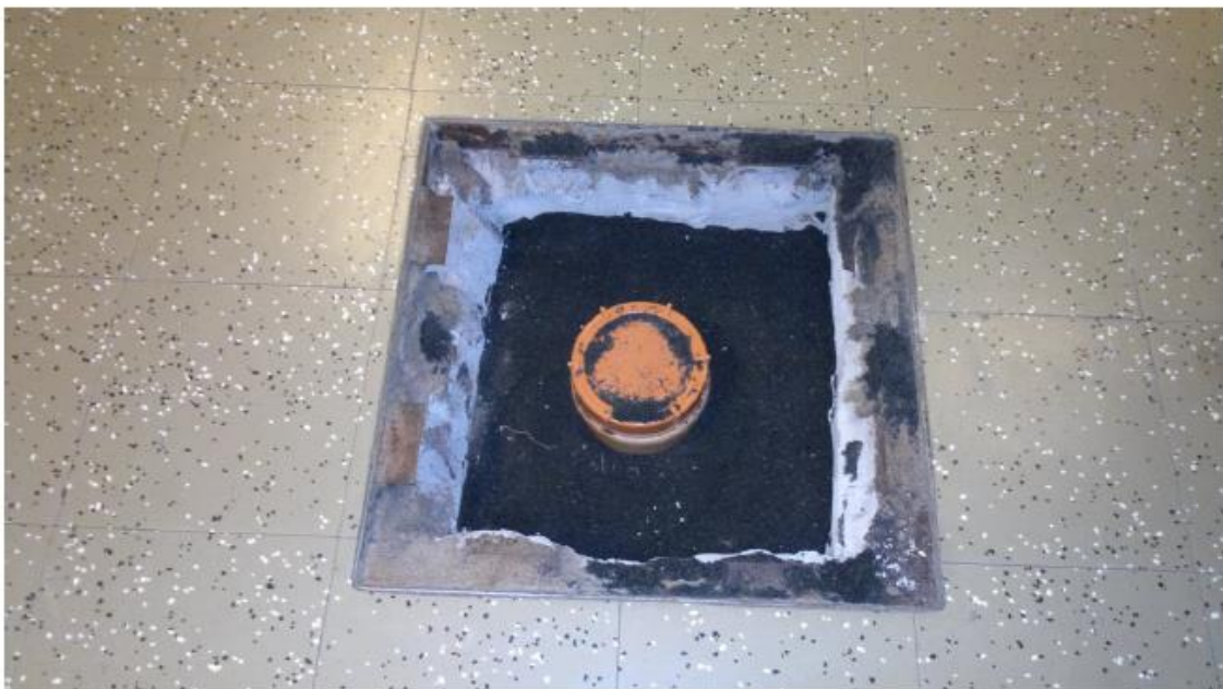
Kuva 2. Putken ympärille levitetty oktomurske
