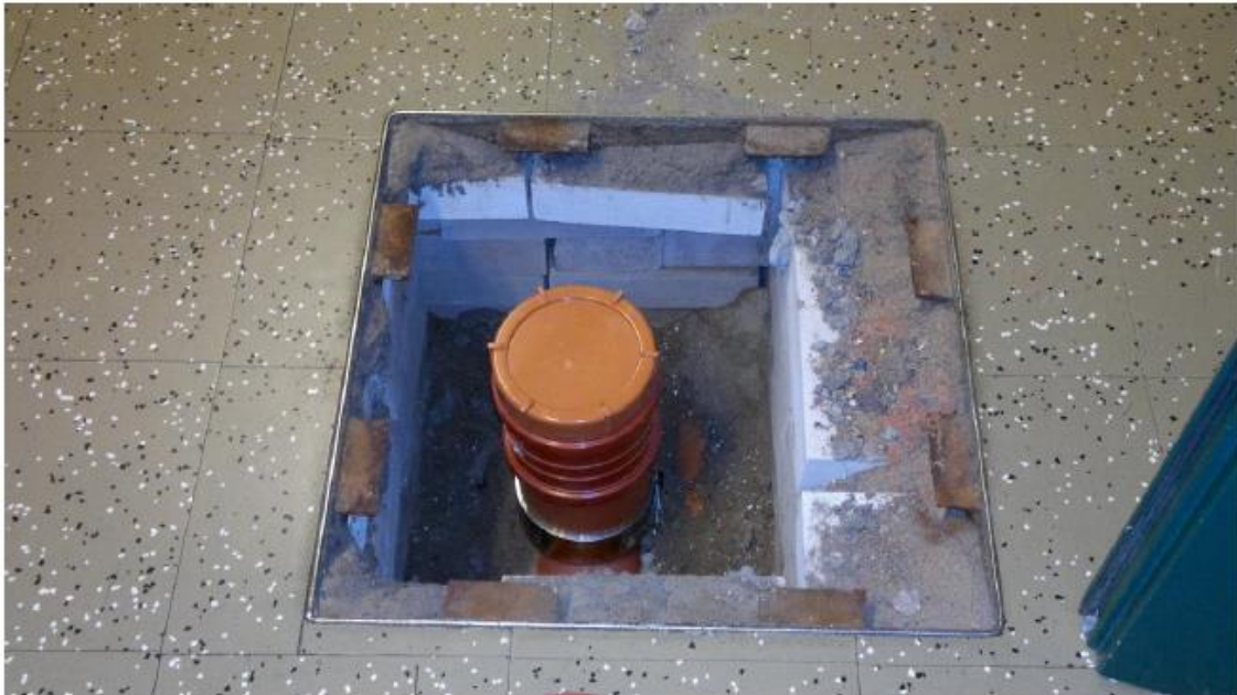
Kuva 1. Putken jatkaminen
