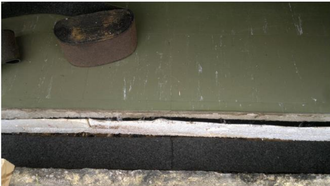
Kuva 3. Uuden seinän rakennus voi alkaa
