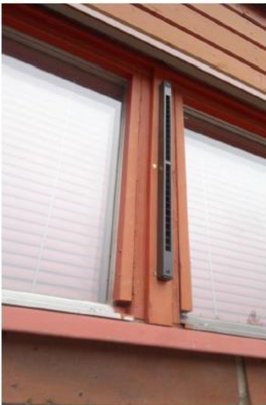
Kuva 3. Korvausilmaventtiili ulkoapäin
