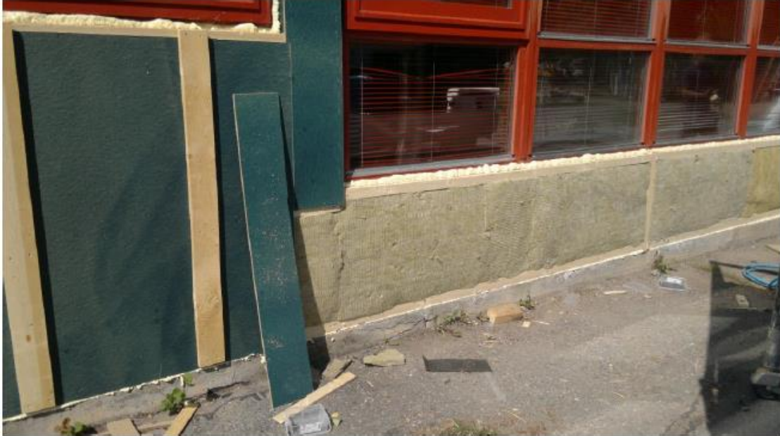
Kuva 5. Ulkokuori valmistumassa
