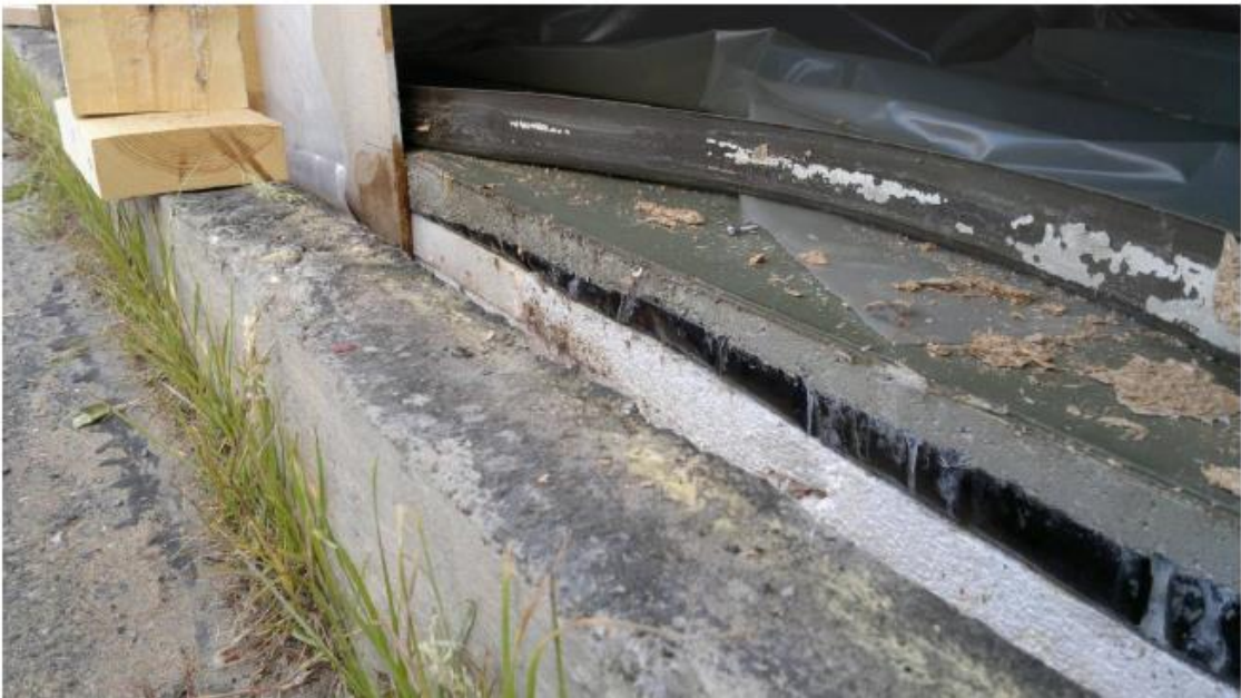
Kuva 2. Lastulevy ja höyrysulku purettu
