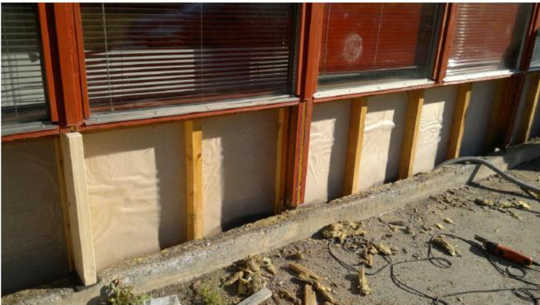
Kuva 2. Aukaistu ulkoseinä
