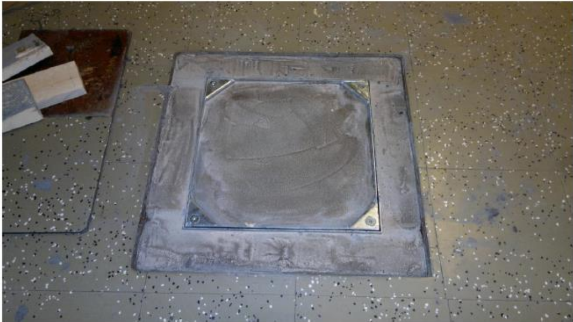
Kuva 5. Kaasutiivin luukunkansi paikoillaan
