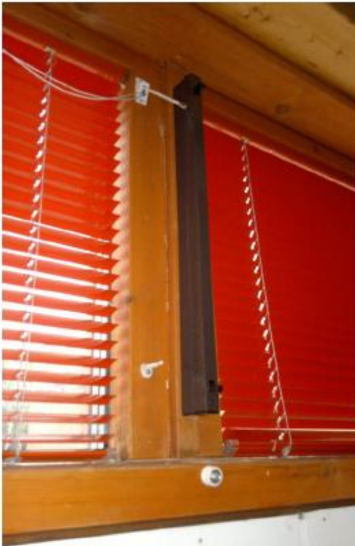
Kuva 2. Korvausilmaventtiili sisältäpäin
