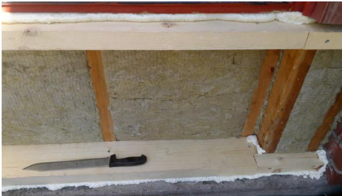
Kuva 3. 150 mm vaakarunko kiinnitetty ja uretaanilla tiivistetyt laidat
