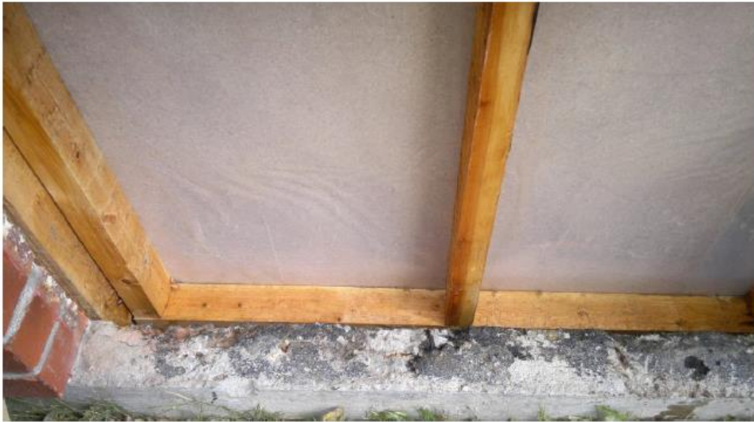
Kuva 1. Purettu, puhdistettu ja home-estetty ikkunaluukku
