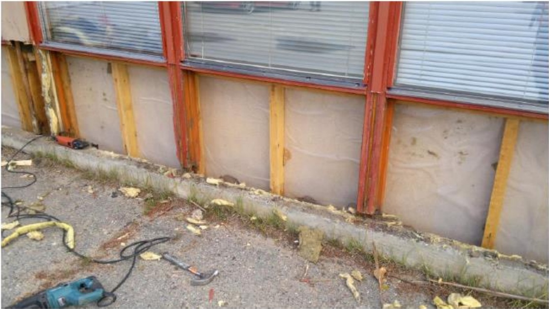
Kuva 1. Luokan 9 seinän ulkopuoli purettuna
