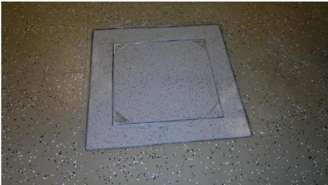
Kuva 6. Valmis kaasutiivis viemärintarkistusluukku
