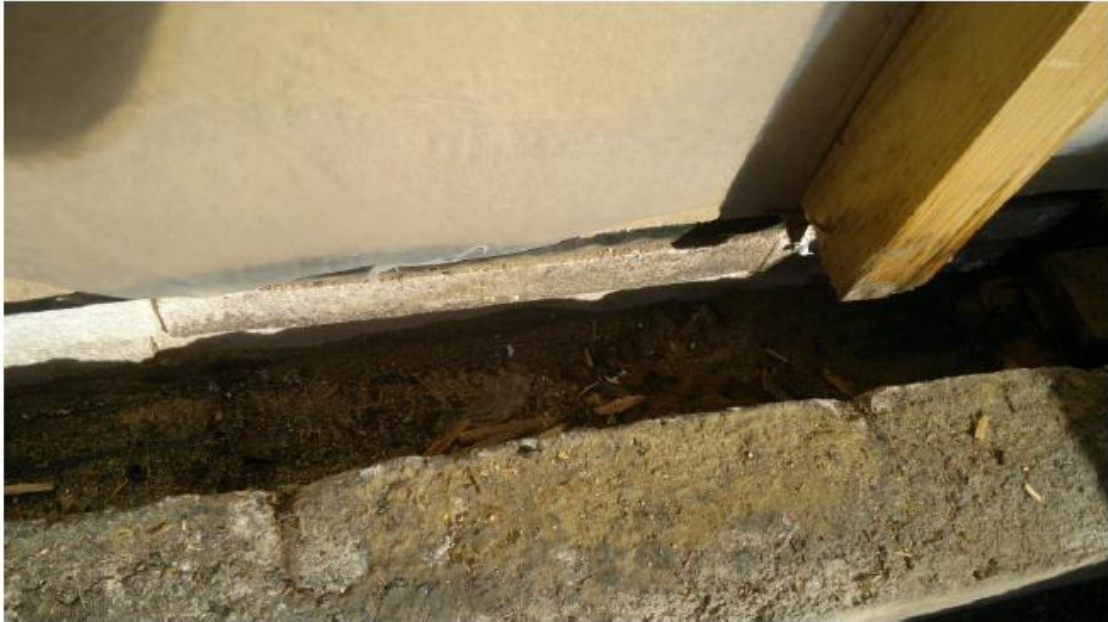
Kuva 3. Runkotolpat katkaistu, alaojhauspuu ja lastulevy poistettu
