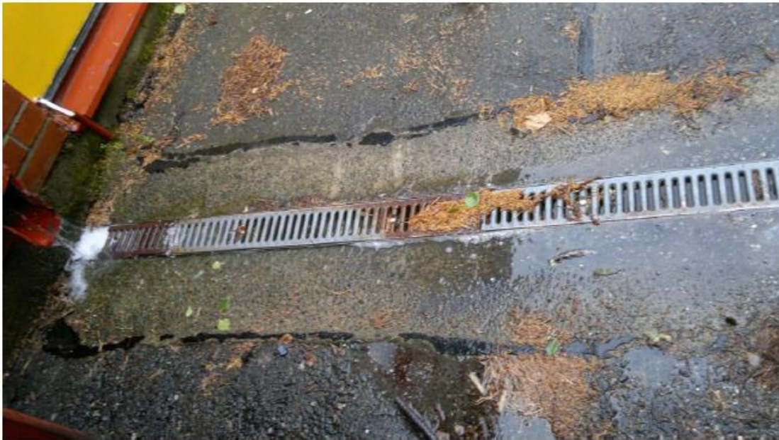
Kuva 1. Puhdistamaton vesikouru
