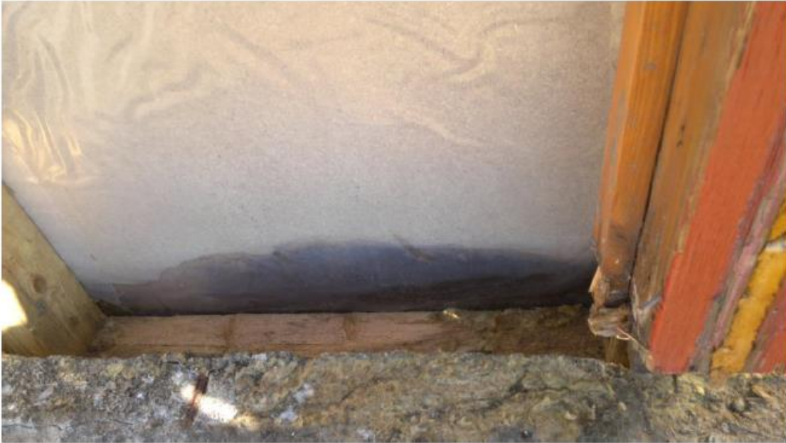
Kuva 1. Vaurioitunut lastulevy
