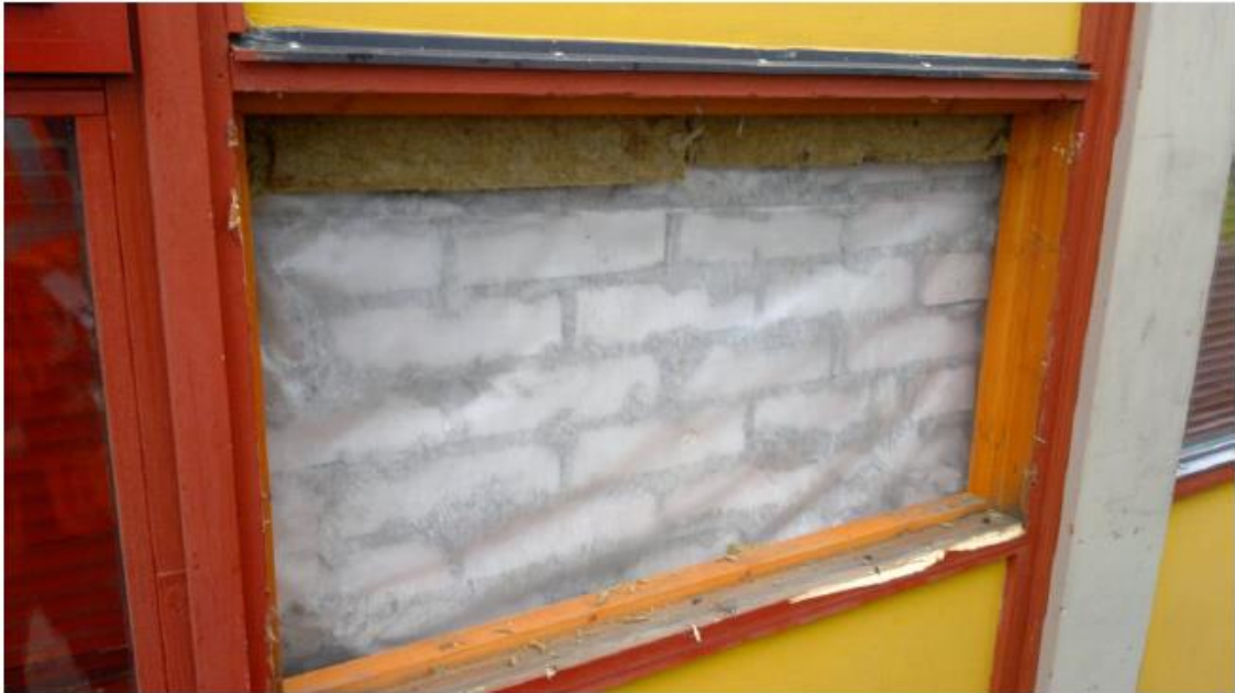
Kuva 1. Liian ohut villaeriste
