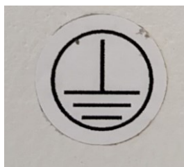
Kuva 1. Sähkökeskuksen kannessa esimerkki suojamaadoituksen symbolista [9].
